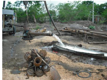
DESARROLLO DE AFORO Y PRUEBA DE BOMBEO.
