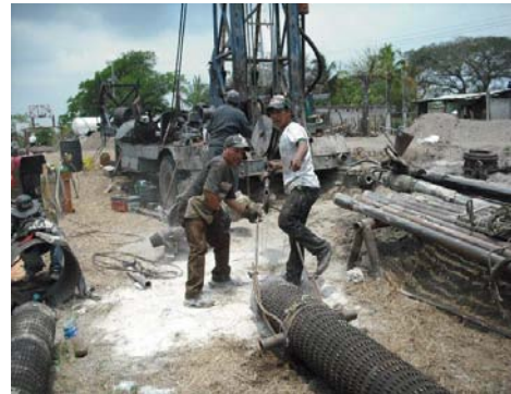
PERFORACION Y COLOCACION DE TUBERIA DE ACERO.
