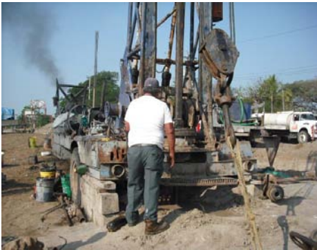
PERFORACION Y COLOCACION DE TUBERIA DE ACERO.
