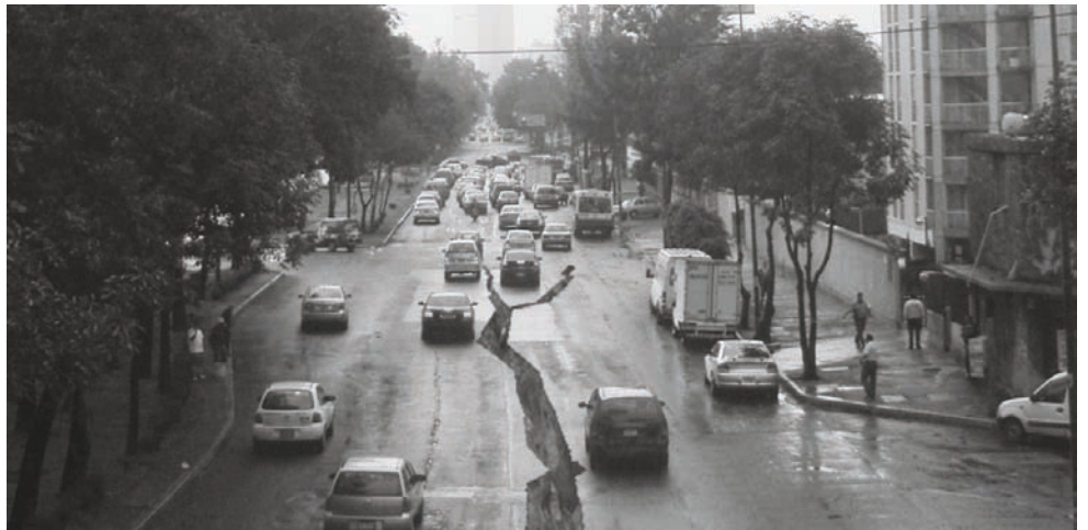
Fractura entre barrios
