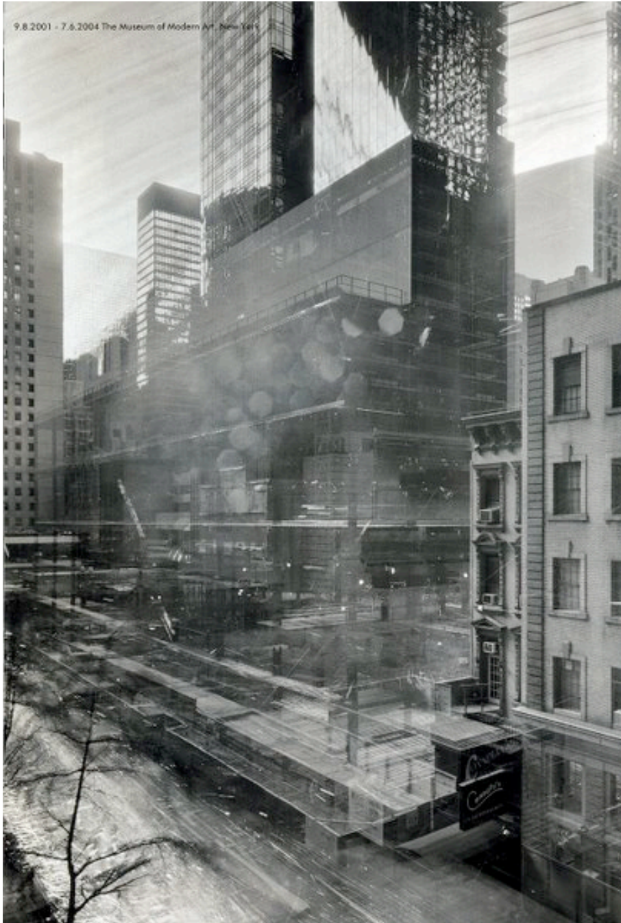
Fotografía a alta exposición del desarrollo constructivo de un edificio.
