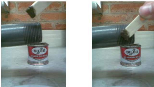
Figura 37: Aplicación de sellador
