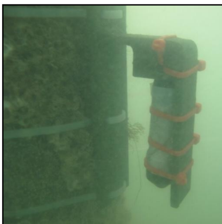
Figura 3.25 LTC instalado en un muelle
