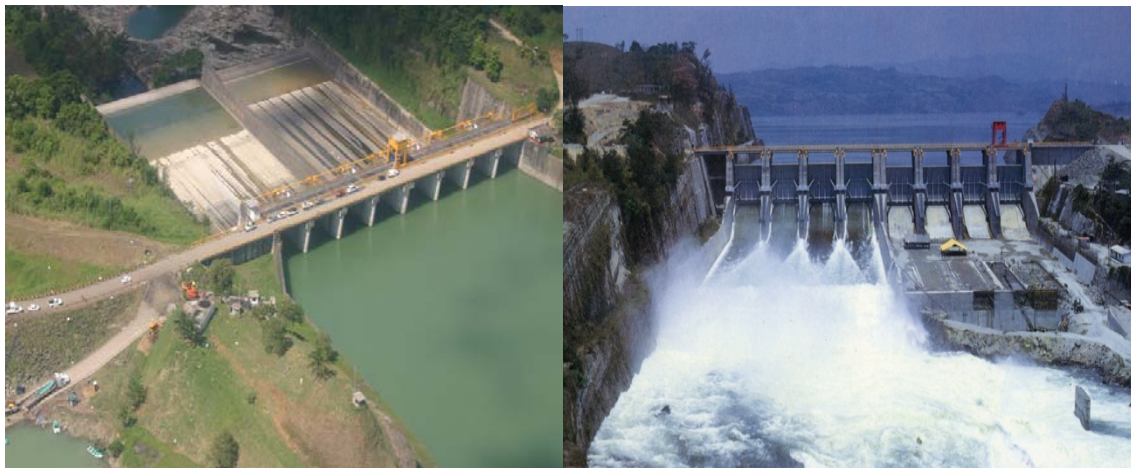
Figura 2.36 (a). Vertedor aguas arriba. Figura 2.36 (b). Vertedor aguas abajo.
