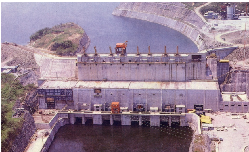
Figura 2.38 (a). Casa de máquinas (perfil). Presa Peñitas.
