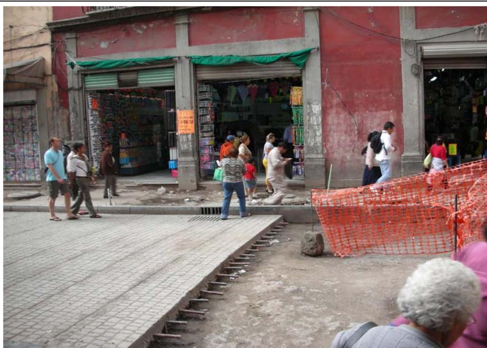
**Imagen II-9.-** Sustitución de carpeta asfáltica por adoquinado en la calle Del Carmen, muestra de las obras llevadas a cabo hasta el momento en gran parte de la zona oriental del Centro Histórico. **Foto:** Resih Omar Hernández Beristáin.
