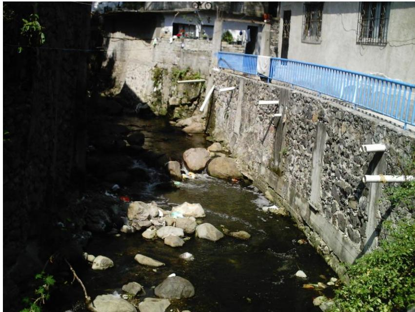
*Figura 6.2 Descarga directa de aguas residuales de viviendas establecidas en ladera de la barranca Chiflón de los Caldos.*
