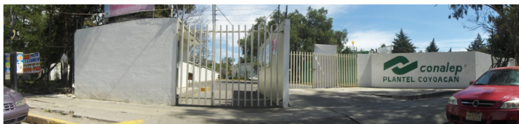
CONALEP, Plantel Coyoacán ( 2 )
