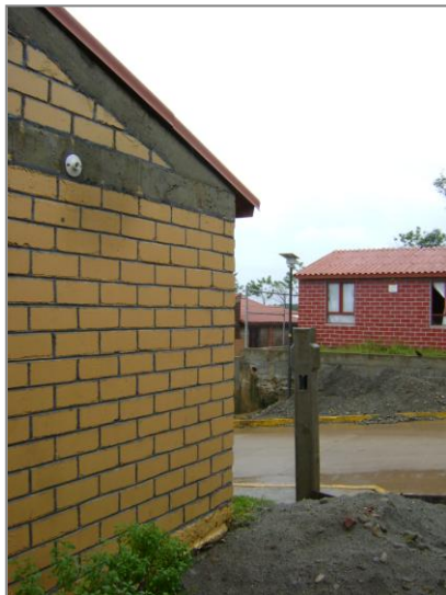
Visual Exterior desde una de las viviendas. Se observa que las fachadas fueron pintadas para evitar filtraciones, sin embargo la solución era mejorar los elementos de protección como son los ALEROS y a nivel perimetral de la vivienda.
