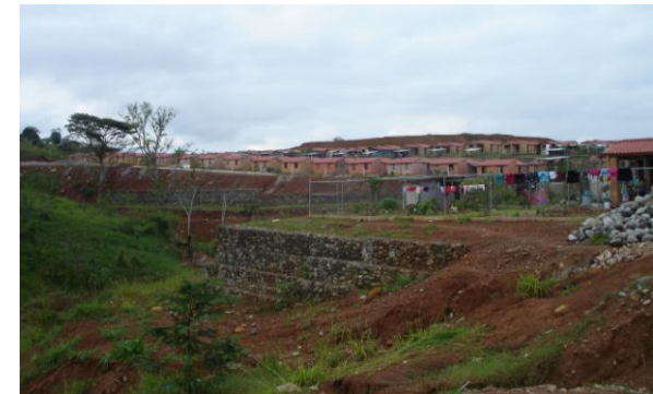
Imagen. Viviendas ubicadas cerca a la micro-cuenca, tratamiento de terrazas para evitar deslizamientos por las continuas lluvias. Tratamiento que se debió realizar igual que la construcción de la CR:
