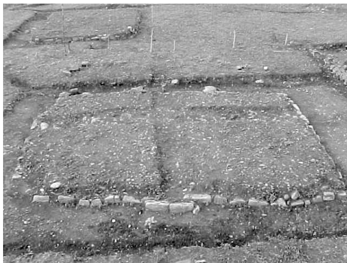
Fig. 78 Vista hacia el norte Estructura 8, con acceso al frente.
