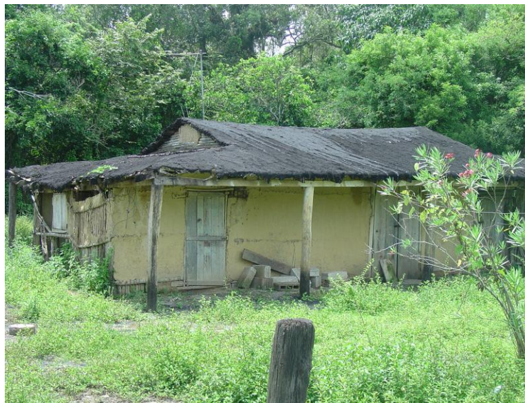
Fig. 18 Techo impermeabilizado con chapopote en Monte Grande, Tantima, Veracruz.
