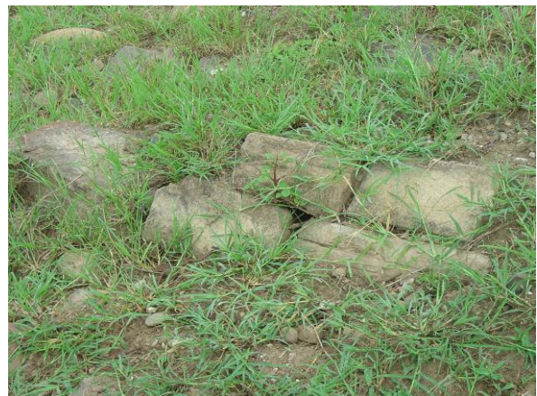
Fig. 217 Detalle muro con arenisca recortada.
