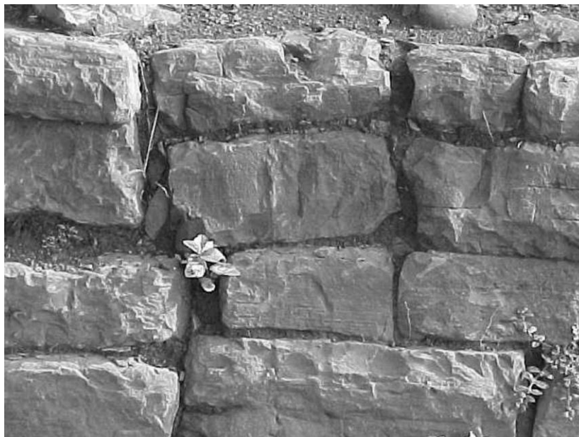
Fig. 53 Muro aparente formado por lajas sin “cuatrapear”.
