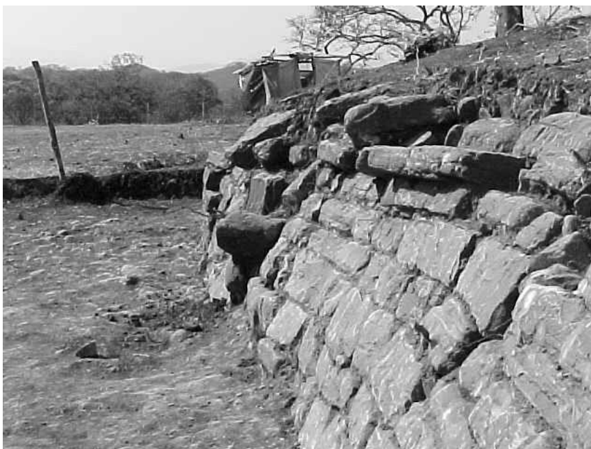
Fig. 69 Vista al sur del muro con cornisa de la Estructura 6.
