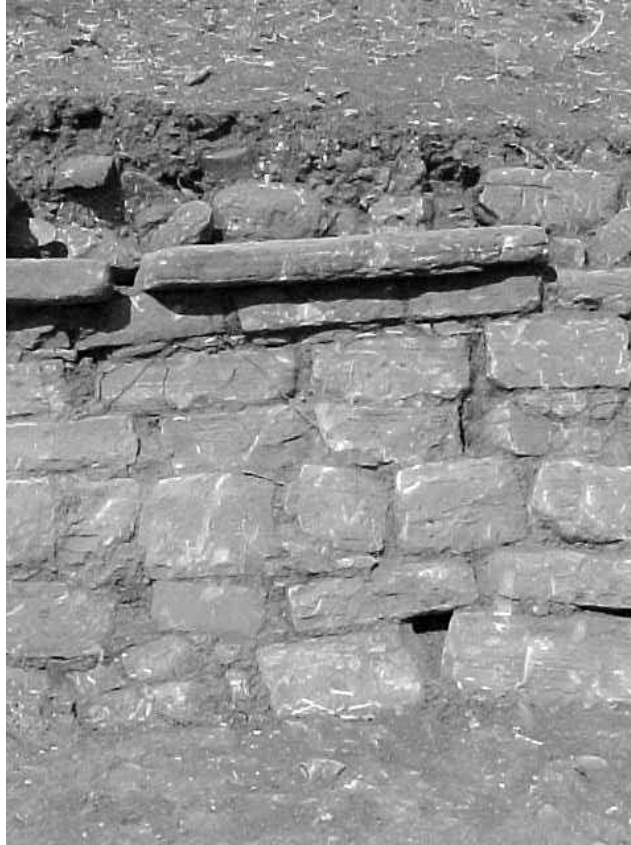
Fig. 70 Detalle cornisa y rajuelas bajo las lajas para nivelarlas.
