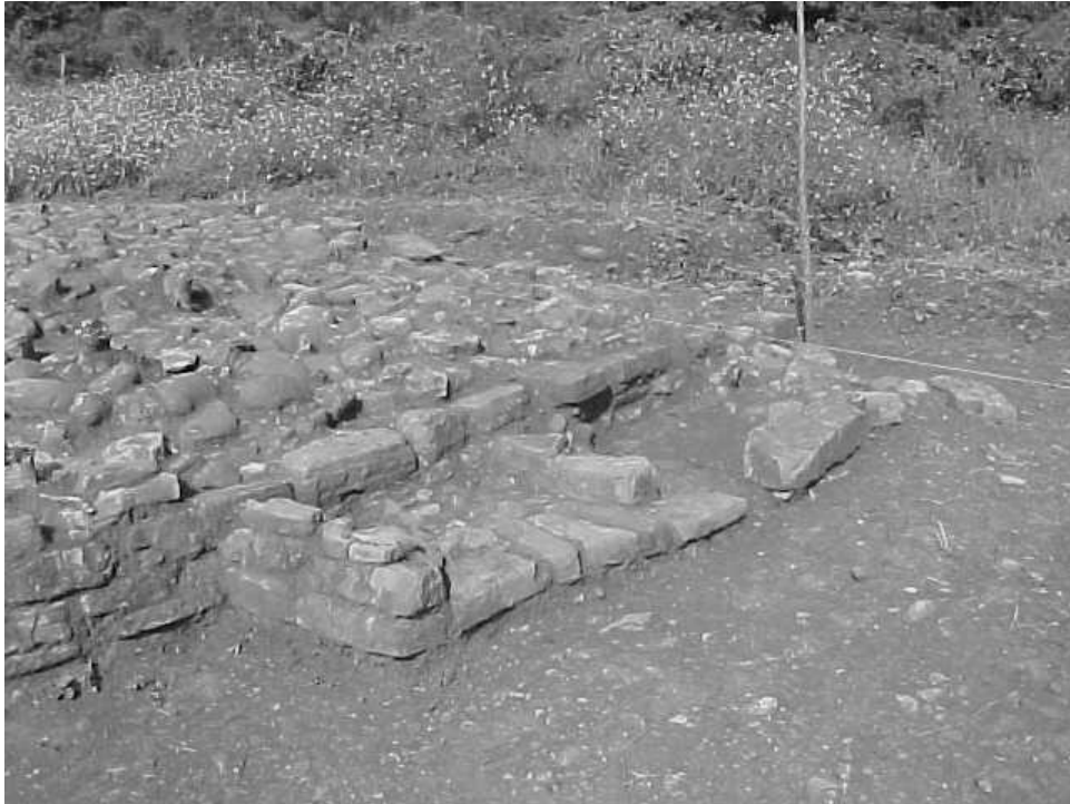
Fig. 59 Elemento rectangular adosado en la esquina noreste.
