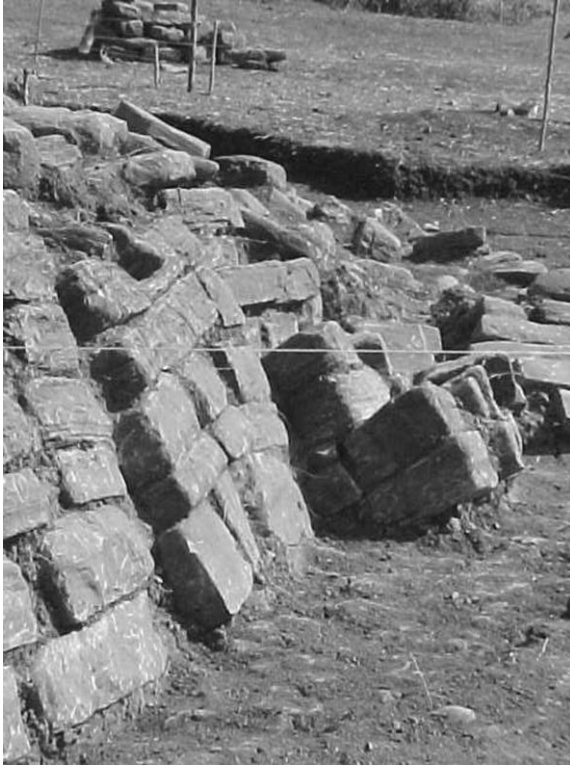
Fig. 51 Unión desplazada entre lienzos.
