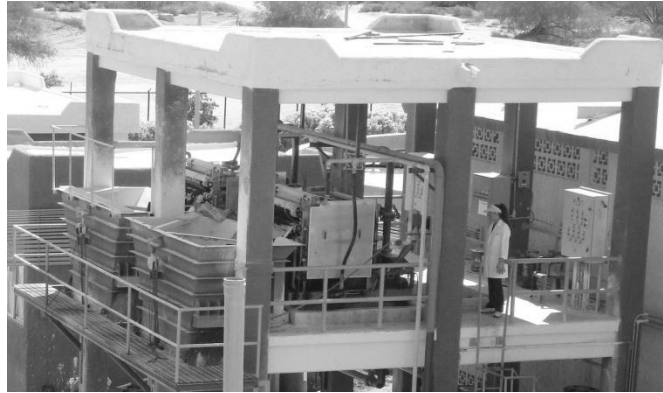
Figura 4.10. Reproducción con permiso del O.O.M.S.A.P.A.S. La Paz. Equipos de filtración de lodos.
