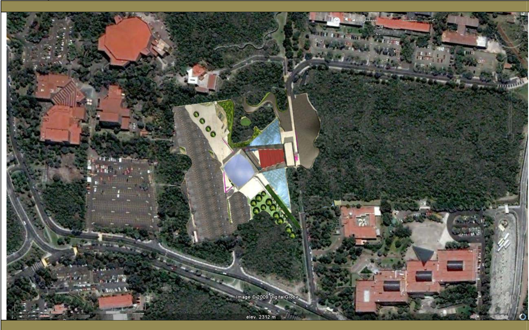
4.10.1 Vista aérea del conjunto y sus edificios vecinos
