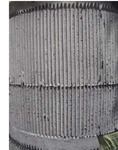
Figura 5. Muro curvo estriado Unidad bibliográfica
