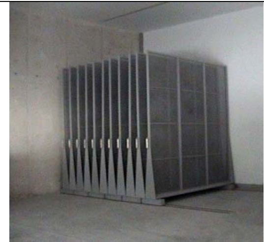
Contiene cortinas, de malla ciclópea moduladas aproximadamente a 3.00 x 4.70m. con rieles para su desplazamiento a cada 30cm. de separación y funciona como resguardo de pintura. Figura 41.
