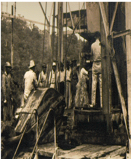
Perforación de pozos. Reproducción realizada con fines didácticos
