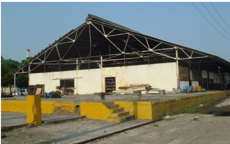
Estado actual del Taller sistema de compresión. Marzo, 2011 Reproducción realizada con fines didácticos
