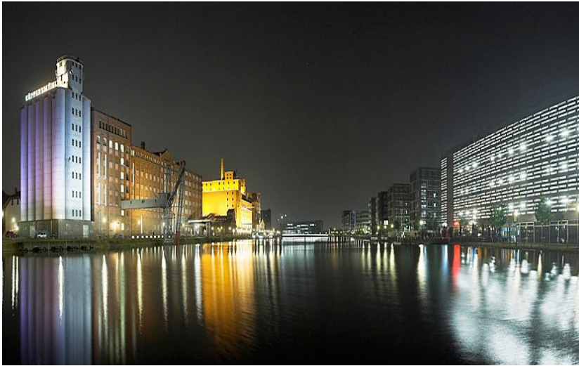
Reconversión del antiguo molino y silos en el Museo Küppersmühle en 1999, elaborado por Herzog y de Meuron. Reproducida con fines didácticos
