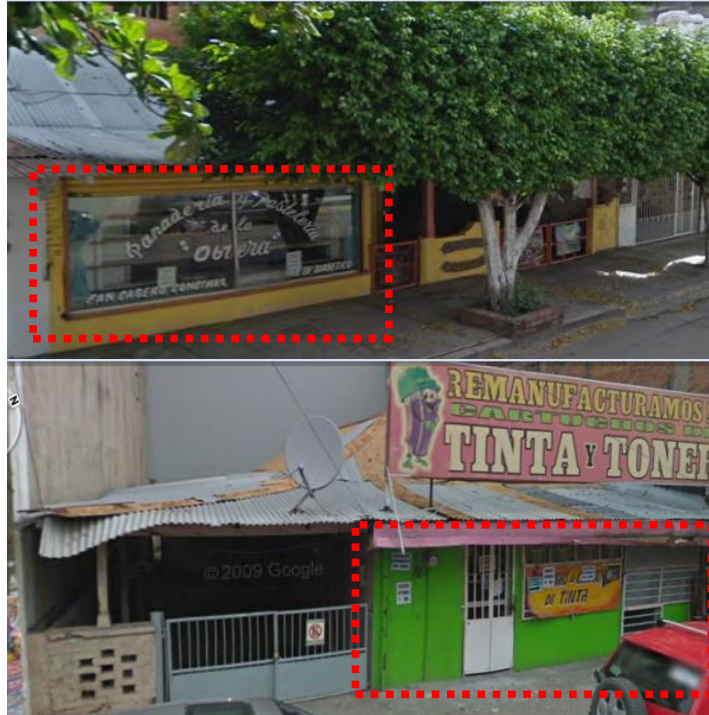
Vivienda Obrera No. 8 y 22, indica reconstrucción de locales. Foto superior: Natali Del Angel. Mayo 2010 Foto inferior: Google Maps. Reproducción realizada con fines didácticos
