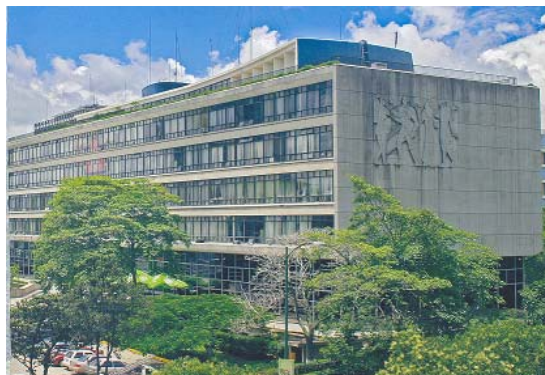
Foto No.117: Fachada Oeste Edificio Municipal Mural "La Conquista" por Guillermo Grajeda Mena Fuente: Revista Galería, 2006
