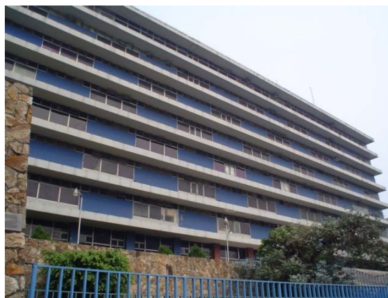
Foto No.124: Fachada Este Instituto Guatemalteco de Seguridad Social Fuente: Sonia Fuentes 2005
