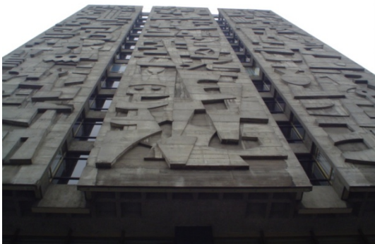
Foto No. 71: Edificio del Banco de Guatemala Fachada oeste (1966) Fuente: Sonia Fuentes (2005)
