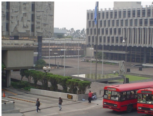
Foto No.134: Fachada Norte Crédito Hipotecario Nacional y Plaza Carlos Mérida Fuente: Sonia Fuentes 2005
