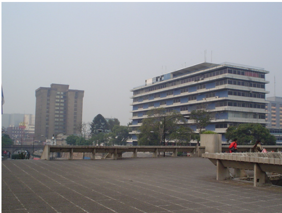
Foto No.35: Pasarela Centro Cívico Guatemala(1966) Fuente: Sonia Fuentes (2005)
