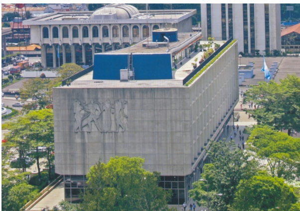
Foto No. 30 Fachada Oriente Edificio Municipal, Guatemala (1958) Fuente: Revista Galería Fundación G&T (2006)
