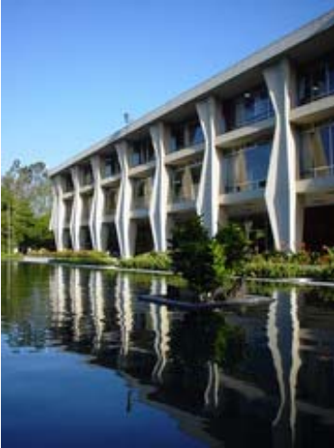
Foto No. 27: Edificio de Rectoría USAC, Guatemala (1960) Arq.. Roberto Aycinena, Arq. Jorge Montes y Carlos Hauessler Fuente: www.panoramio.com/user/1543
