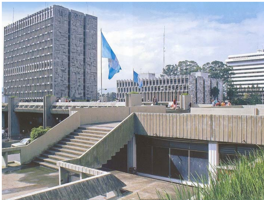
Foto No.86: Vista de la integración de pasarelas a los edificios del Banco de Guatemala y Crédito Hipotecario Nacional Fuente: Revista Galería G&T, 2006
