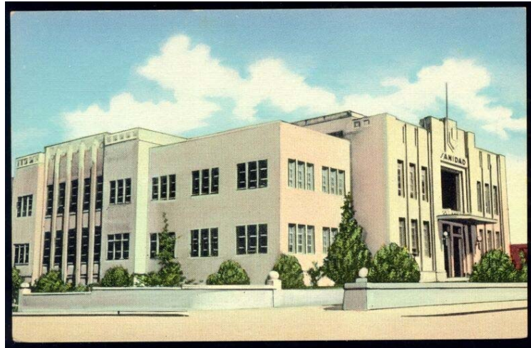
Foto No. 12 Edificio de Sanidad Pública, Guatemala (1937) Arq. Pérez de León Fuente: www.photobucket.com/.../raguiluz/1940
