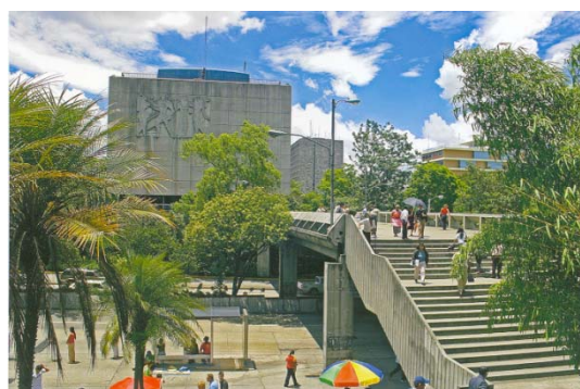
Foto No.119: Fachada Oeste Palacio Municipal y pasarela sobre la 7ª Avenida Zona 1 Fuente: Revista Galería, 2006
