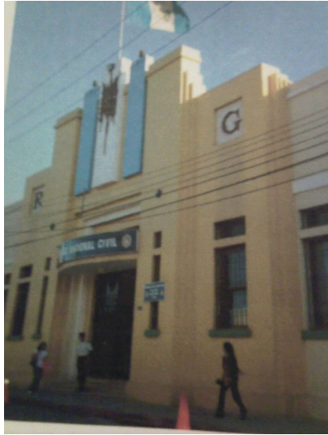
Foto No.9: Antiguo Edificio de Aduana, Guatemala, (1936) Fuente: Lionel Bojórquez (2008)
