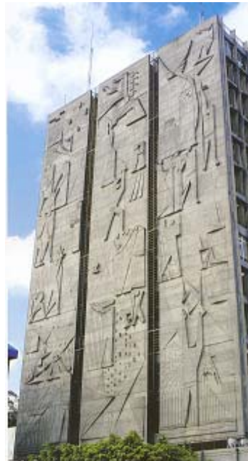
Foto No.96: Fachada Este Edificio Banco de Guatemala Fuente: Sonia Fuentes, 2006
