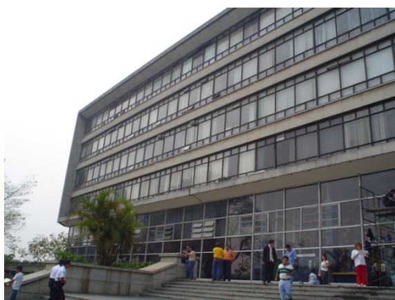
Foto No.114: Fachada Norte Edificio Municipal Fuente: Sonia Fuentes(2005)
