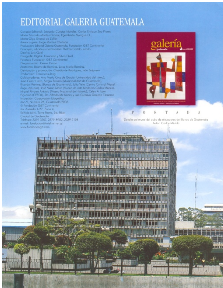
Foto No. 80: Fachada Norte Banco de Guatemala
