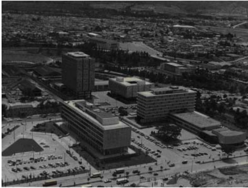
Foto No. 15: Edificios Centro Cívico Guatemala Primera Fase (1967) Fuente: www.prensalibre.com
