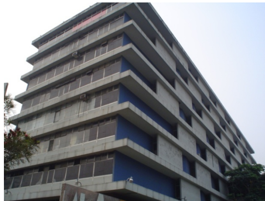
Foto No.122: Fachada Este Instituto Guatemalteco de Seguridad Social Fuente: Sonia Fuentes 2005
