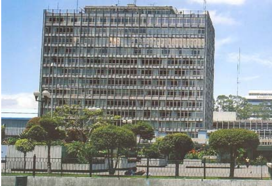
Foto No.83: Fachada Norte Banco de Guatemala Fuente: Revista Galería Fundación G&T, 2006
