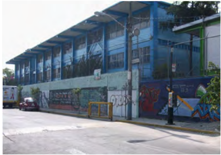
Foto No. 11: Conjunto de equipamientos en calle 18
