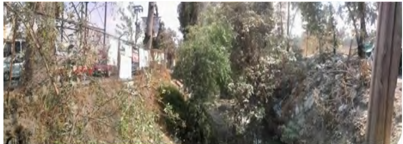
Foto No. 3: Canal de aguas negras a cielo abierto
