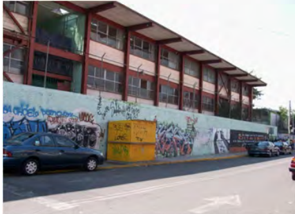
Foto No. 20: Conjunto de equipamientos en calle 18, barda perimetral con grafiti
