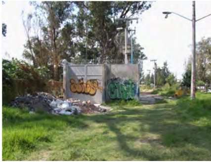
Foto No. 19: Espacio remanente en Canal de Chalco
