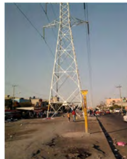
Foto No. 9: Camellón en Av. de las Torres
