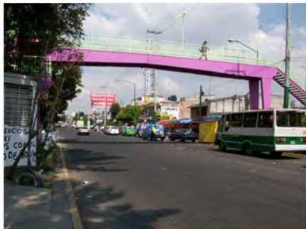
Foto No. 12: Puente peatonal en Anillo Periférico
