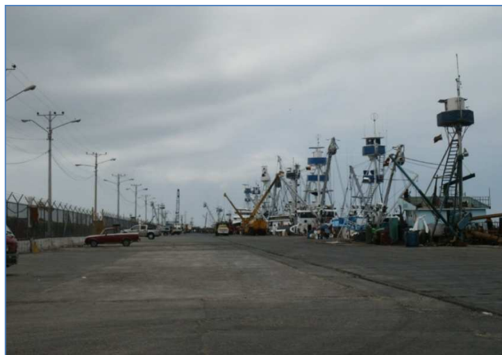
Figura 5 Muelle marginal (Fuente: Puerto de Manta, Ecuador. Proyecto de expansión del puerto)
