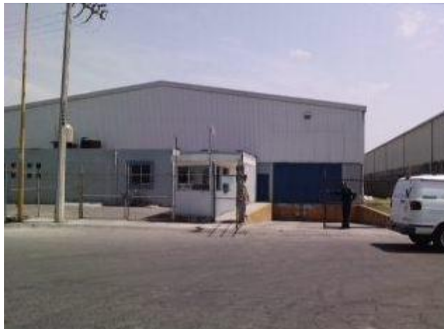
Fig. 41 13 Nave Industrial Parque Toluca 2000
