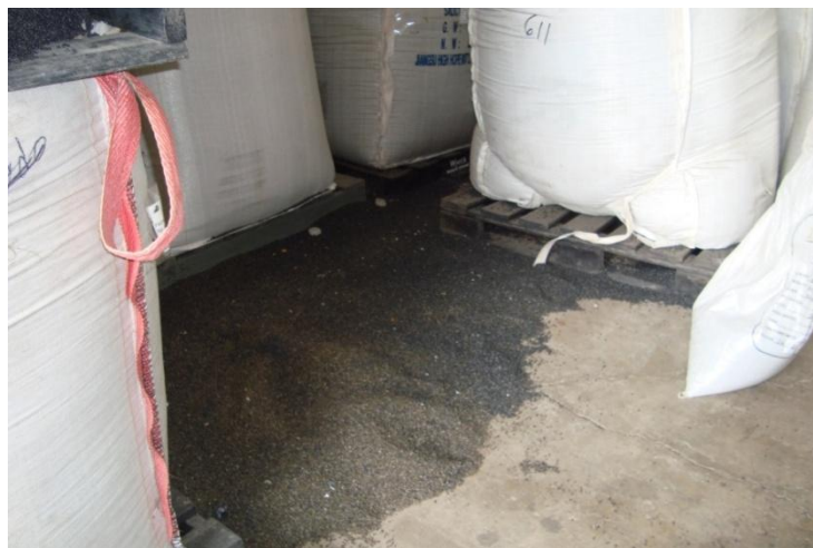
Fig. 61 Imagen donde se muestra la falta de limpieza en almacén
