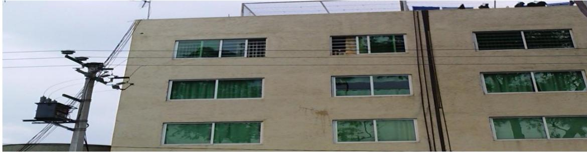
Figura 5.7 Líneas de mediana tensión muy cerca de edificio y ventanas.
