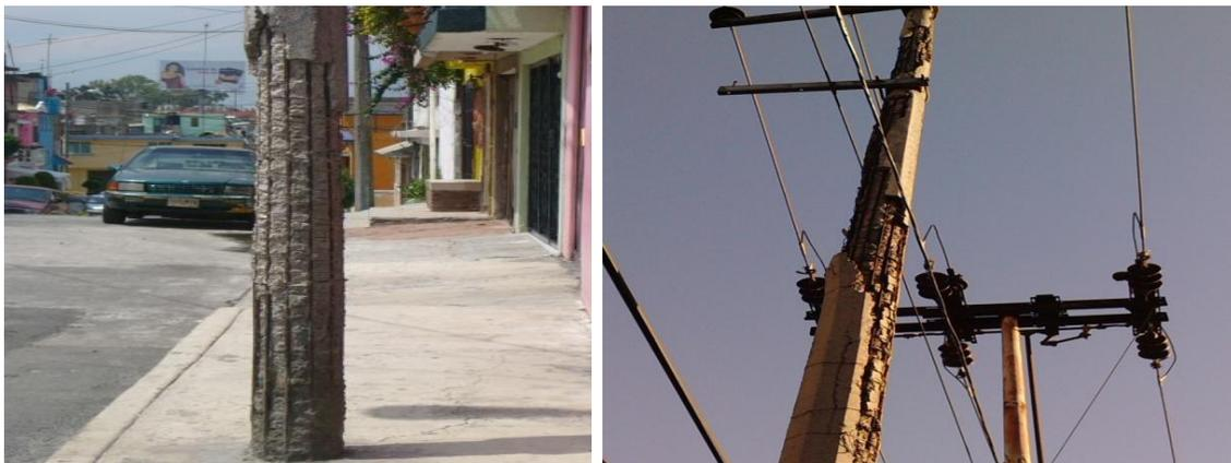
**Figura 4.13 Postes de concreto reforzado con las varillas expuestas muy deteriorado por el tiempo que datan de los años 60's.**
