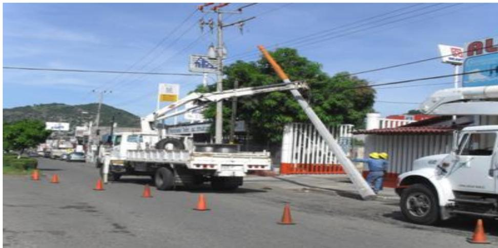
**Figura 1.33 Brazo hidráulico colocando poste de concreto.**
