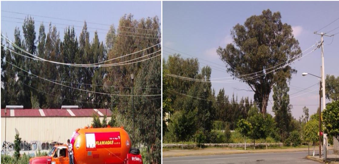
**Figura 4.14 Línea de mediana tensión con exceso de catenaria muy peligrosa.**
