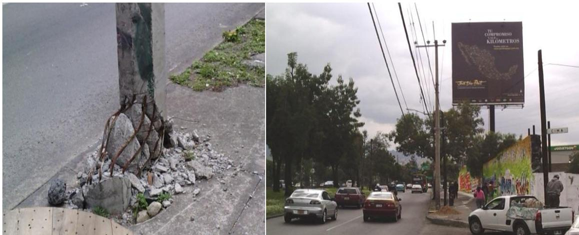
**Figura 5.9 Poste de concreto reforzado CR- 14 chocado y recorrido de su base.**
