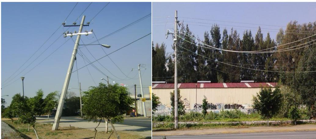
**Figura 2.4 Exceso de catenaria en poste desplomado con líneas de mediana tensión.**
