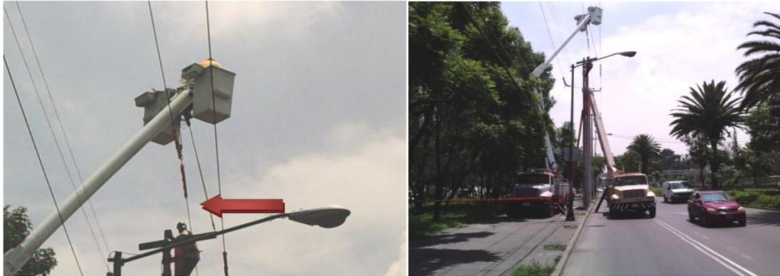
Figura 5.1 Trabajos con línea viva (LV), trabajos con potencial de mediana tensión.
