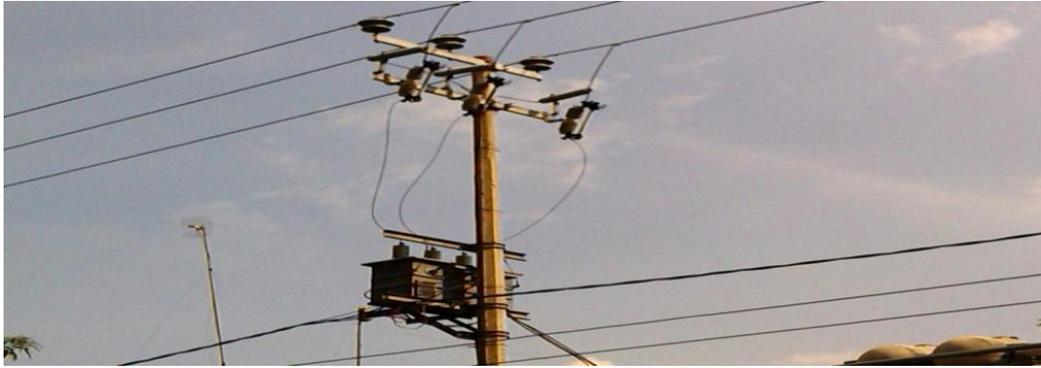
**Figura 1.39 Transformador instalado en la red troncal.**
