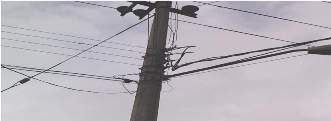
Figura 1.52 Transición de línea trenzada a línea abierta mejor conocida como red de distribución de baja tensión mixta.
