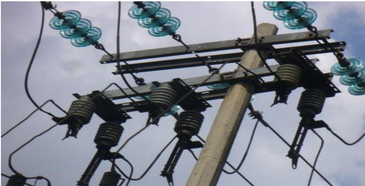
**Figura 1.24 Cuchillas invertidas manuales con cortador.**
