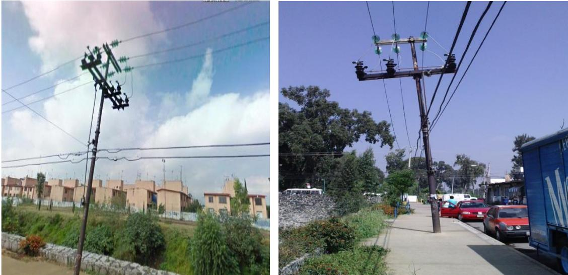
**Figura 4.8 poste de acero troncocónico con equipo de seccionamiento manual desplomado con red troncal.**
