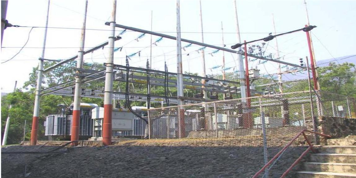
**Figura 1.8 Subestación eléctrica reductora de intemperie.**
