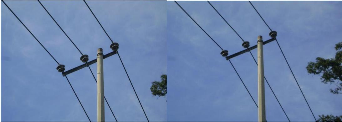
**Figura 5.14 Aisladores de porcelana en mal estado a punto de zafarse de sus soportes y su cruzeta muy inclinada.**
