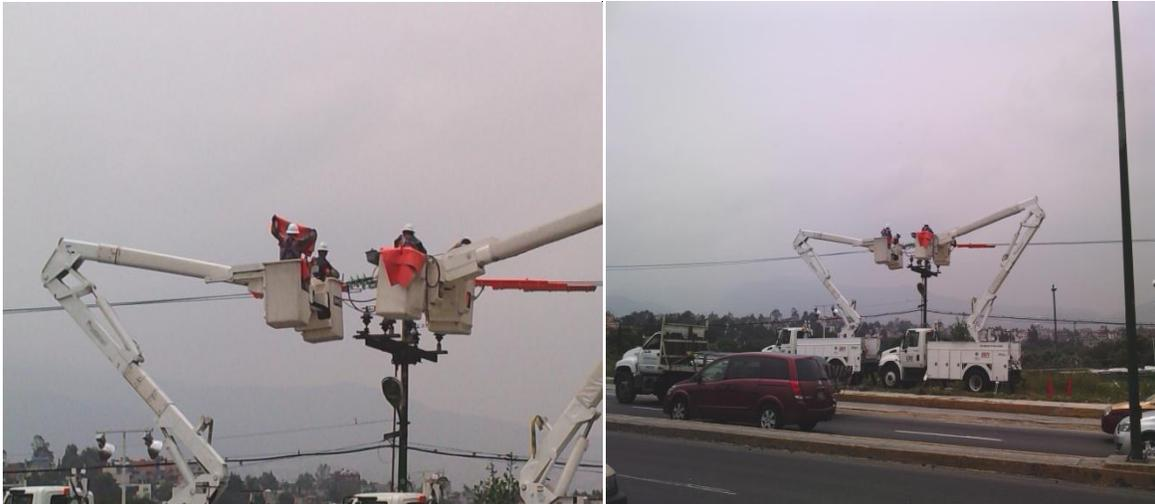
Figura 5.17 Mantenimiento con línea viva a unas “cuchillas” ALDUTI.
