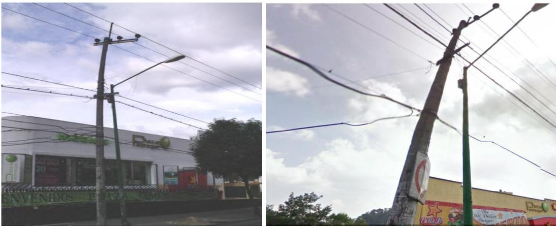
**Figura 5.11 Poste de concreto reforzado CR-14 muy deteriorado por el tiempo y a punto de caer.**
