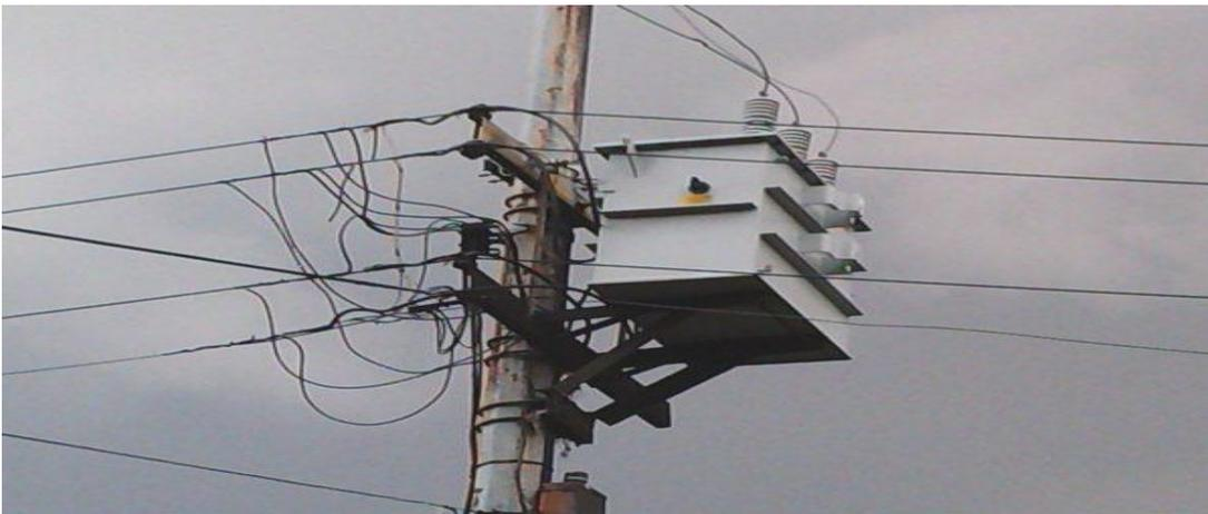
**Figura 1.46 Salidas de transformador y tendido aéreo de línea abierta de distribución de baja tensión.**
