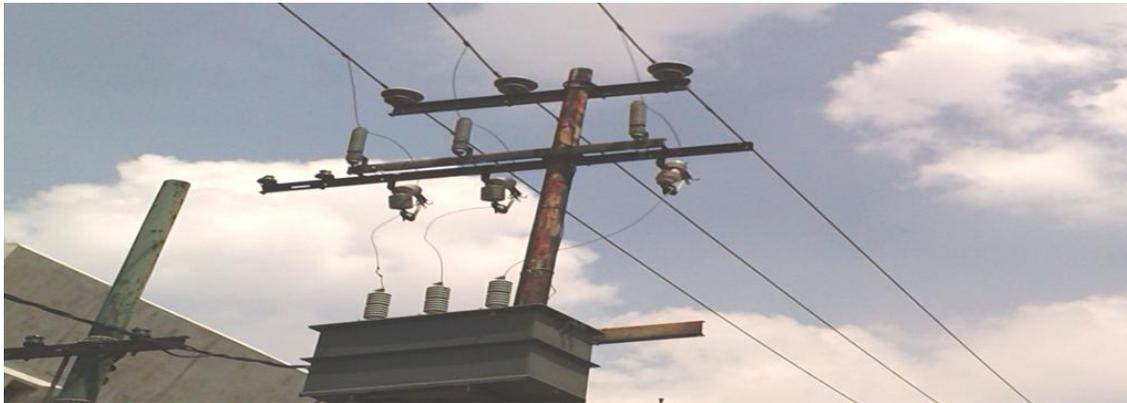
Figura 1.20 Transformador trifásico aéreo.
