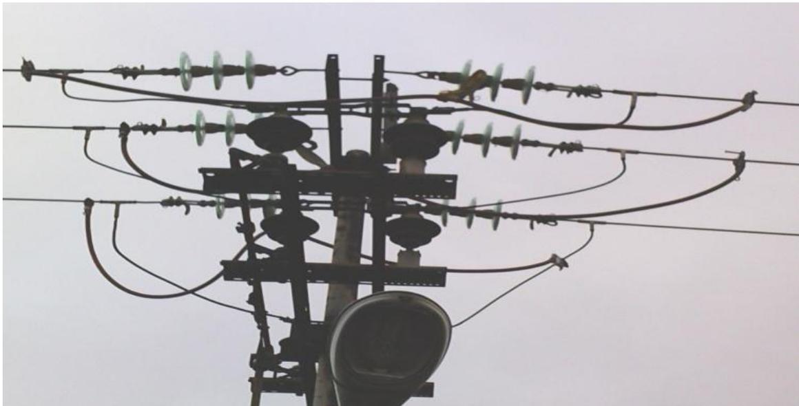
**Figura 5.16 “cuchillas” tipo ALDUTI sin mantenimiento.**
