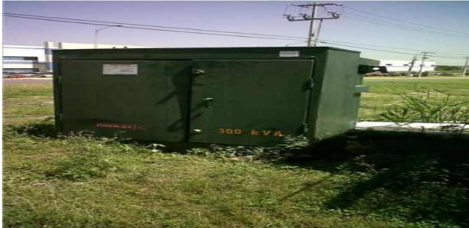
**Figura 1.44 Transformador trifásico de pedestal.**
