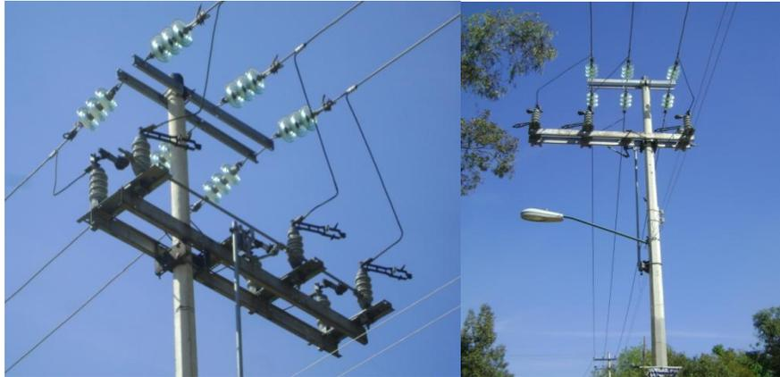
Figura 1.34 Poste de concreto reforzado con equipo manual de seccionamiento.
