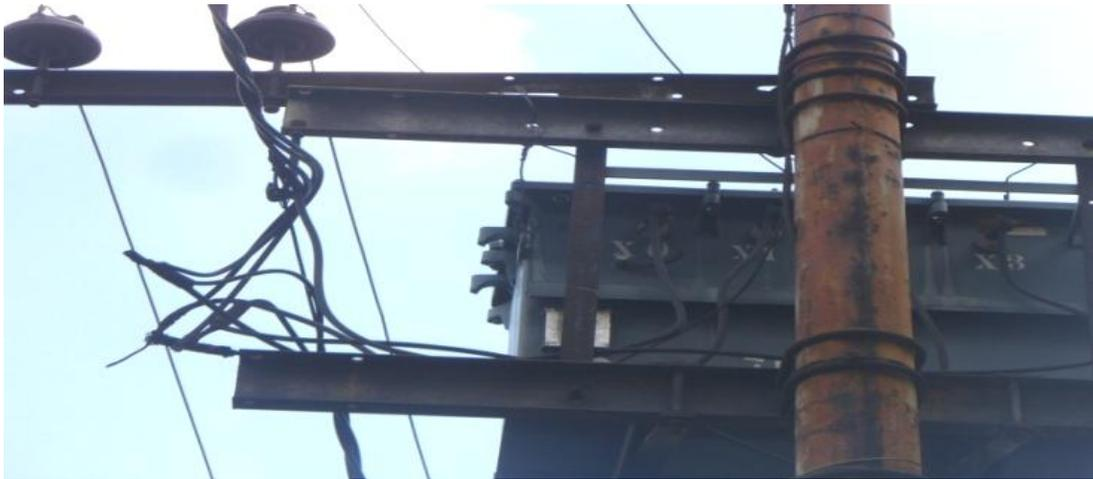
**Figura 1.50** Cable trenzado de baja tensión de calibre de 1/0 en la salida de transformador trifásico aéreo.
