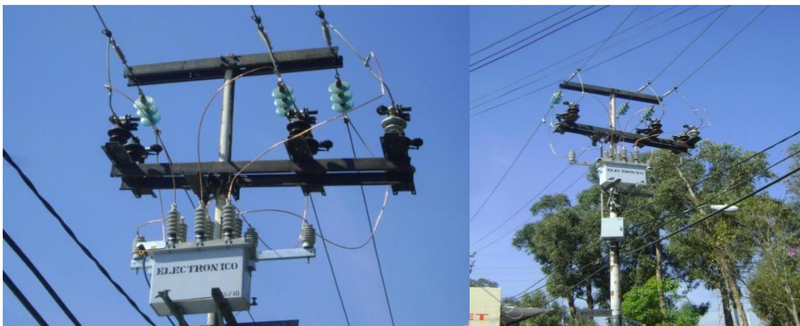
Figura 1.35 Poste de acero troncocónico A-17 con plataforma, y seccionador automático.
