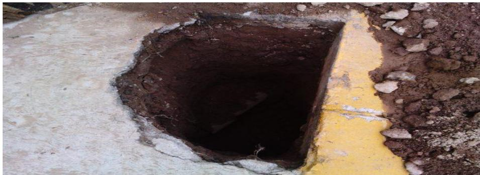
**Figura 1.32 Excavación para poste de concreto reforzado.**
