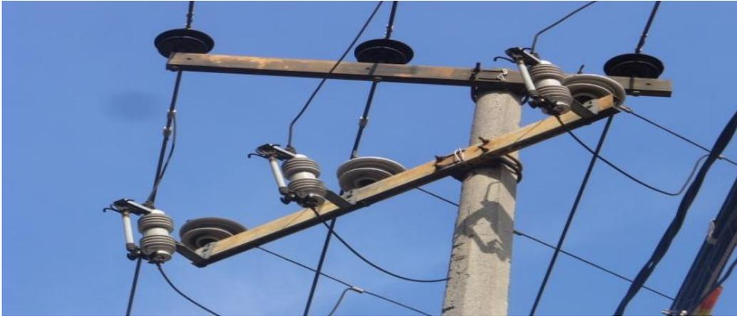
Figura 1.37 Derivación de línea troncal de cable ACSR de calibre 336 a línea primaria o ramal de cable ACSR de calibre de 1/0.
