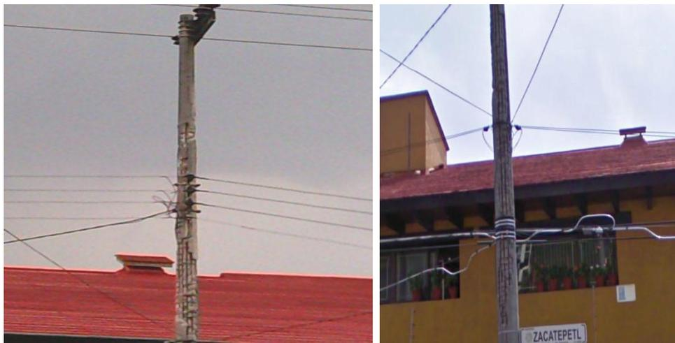
**Figura 4.3** poste de concreto reforzado muy deteriorado por el tiempo.
