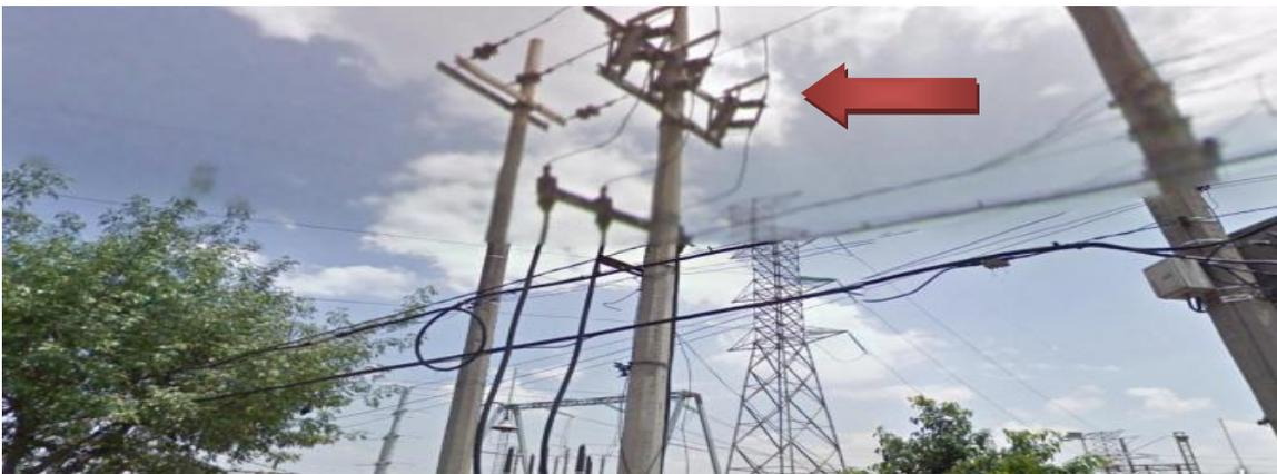
**Figura 1.26 “Cuchillas” interruptoras primeras de salida de la subestación reductora San Ángel.**
