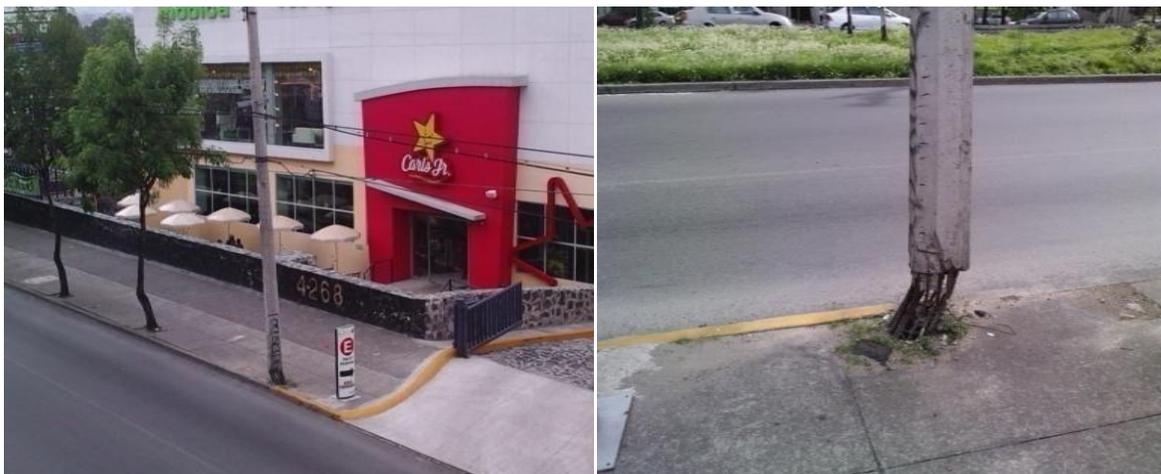
**Figura 5.10 Poste de concreto reforzado CR-14 chocado y recorrido de su base con mucho tiempo deteriorado.**
