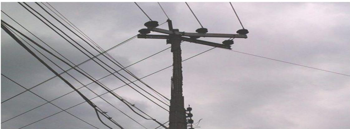
Figura 5.12 Poste CR-14 muy deteriorado por el tiempo con las varillas expuestas a punto de caer.
