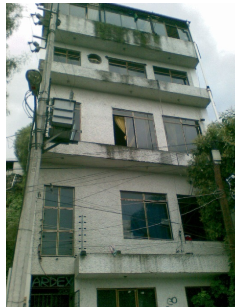
Imagen 1 Fachada del edificio de corte.
