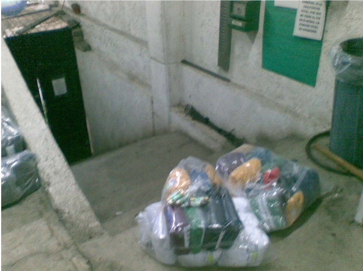
Imagen 12 Bolsas de producto terminado como obstáculo de la única salida del edificio
