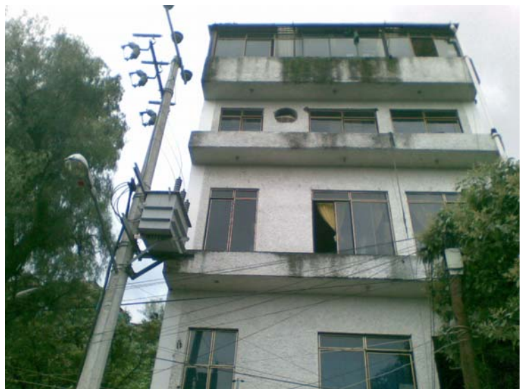
Imagen 2 Fachada del edificio de corte.
