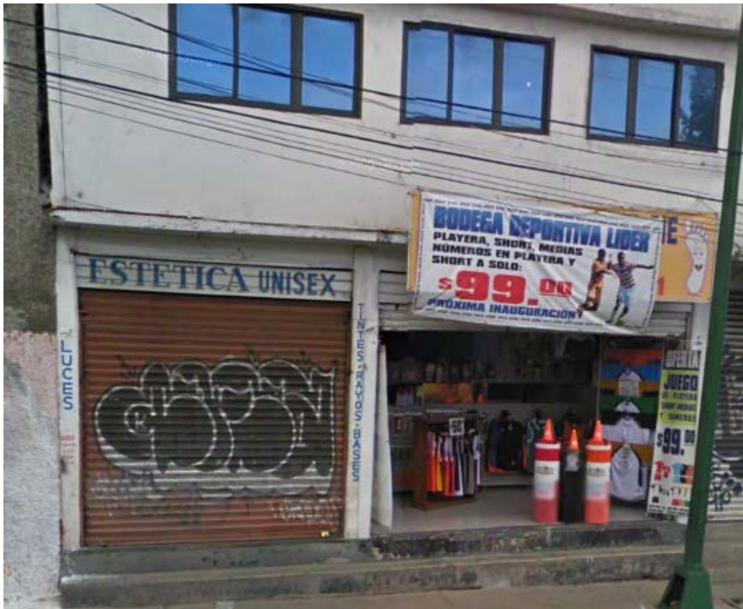
Imagen 11 Fachada del punto de venta Iztapalapa
