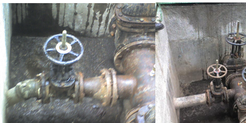
Figura 3.8. Reducción de diámetros en la red. Izquierda: Reducción campana. Derecha: Tee reductora.
