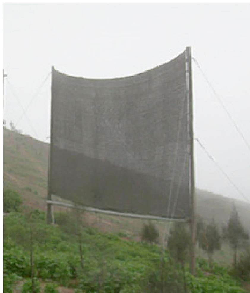
Figura 60 : Atrapa niebla Fuente: <http://sustentator.com/blog-es/2009/07/13/atrapa-nieblas-cientos-de-litros-de-agua-al-dia/>
