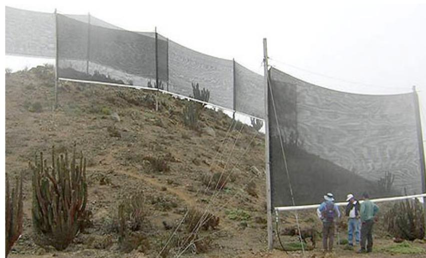
**Figura 58** : Atrapanieblas en Falda Verde, cerca de Chañaral, en el norte de Chile. La malla capta el agua en la niebla que avanza desde la costa (camanchaca para los habitantes del norte chileno) originada en las nubes sobre el Pacífico. (Foto: Universidad Católica de Chile) **Fuente** : [http://www.bbc.co.uk/mundo/participa/2009/04/090422\\_participa\\_atrapanieblas\\_gal\\_am.shtml](http://www.bbc.co.uk/mundo/participa/2009/04/090422_participa_atrapanieblas_gal_am.shtml)
