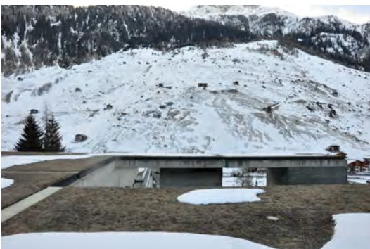
F. as43 Cubierta vegetal. Therme Vals, Peter Zumthor, Graubünden, Switzerland, 1996. Fotografía: Guillermo Rendón Sánchez
