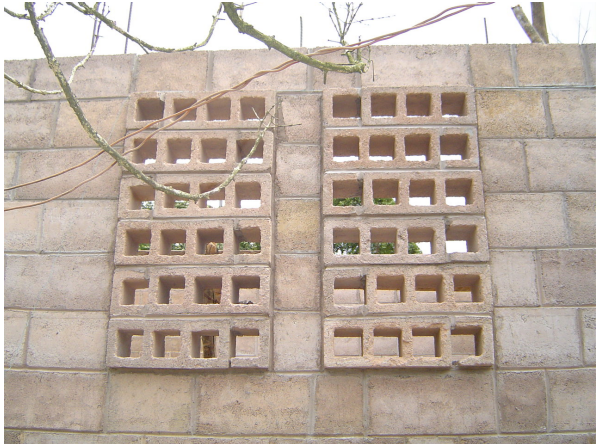
Foto 62; Otro tipo de ventana de celosía
