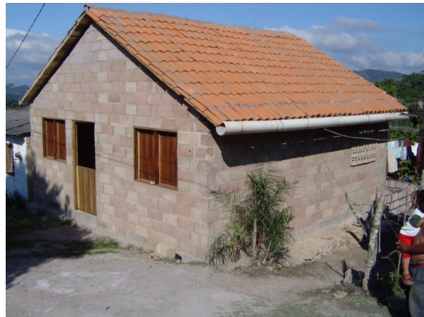
Foto 48; Vivienda mejorada con captación agua de lluvia en la cubierta y se canaliza al tanque.
