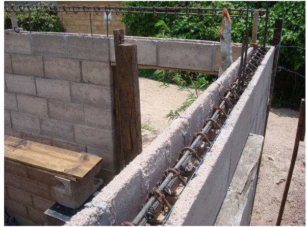
Foto 60; Colocación de refuerzo horizontal interior
