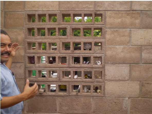
Foto 61; Ventanas de celosía hecha de block
