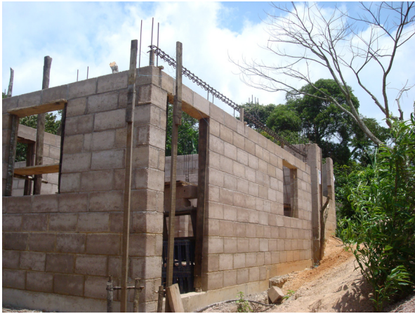
Foto 59; Preparación para cadena de cerramiento
