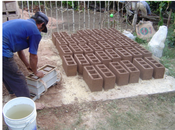
Foto 54; Fabricación del block in situ , en la imagen el señor Jesús
