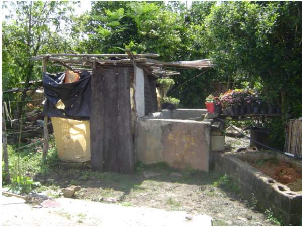
Foto 31; Letrina al lado del tanque de agua.
