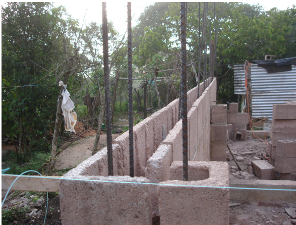
Foto 57; Preparación en paredes para refuerzo
