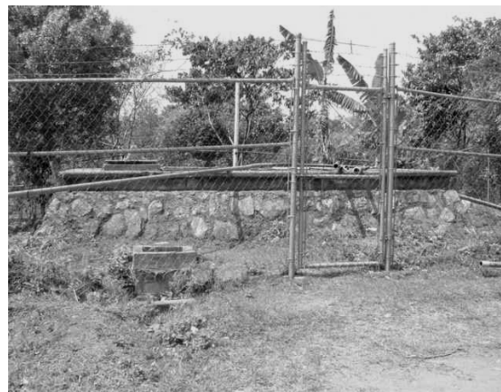
Foto 6; Tanque de regulador “Paso Coyol”
