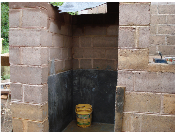
Foto 65; Área de aseo corporal en proceso de construcción.
