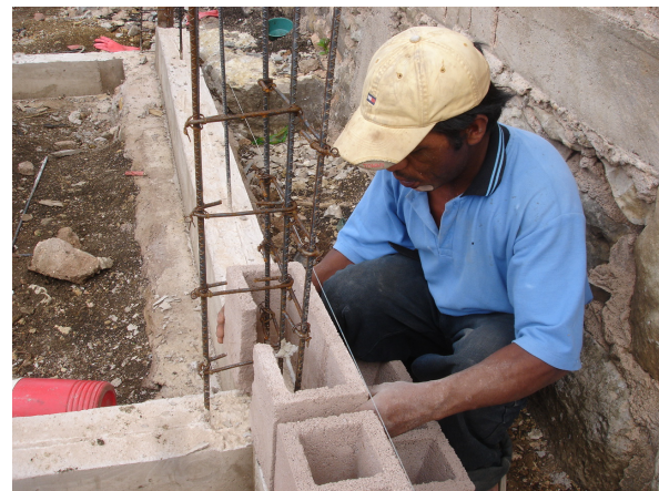
Foto 56; Fabricación de piezas especiales para colocar refuerzo interior. En la imagen, el señor Crescencio.
