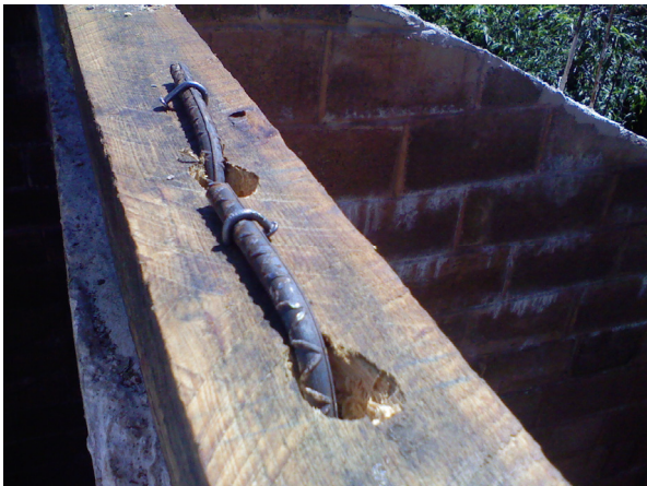
Foto 63; Detalle de anclaje de estructura de madera
