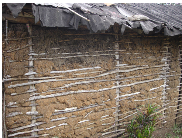
Foto 28; Detalle del entramado y embarro de lodo.
