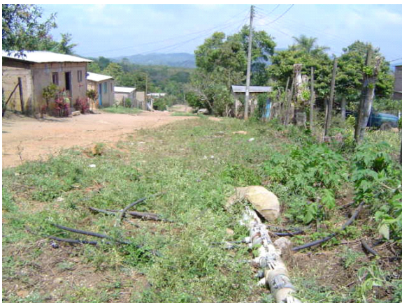
Foto 9; Red superficial de agua de 3” y conexión de tubería negra para abastecer a la vivienda.
