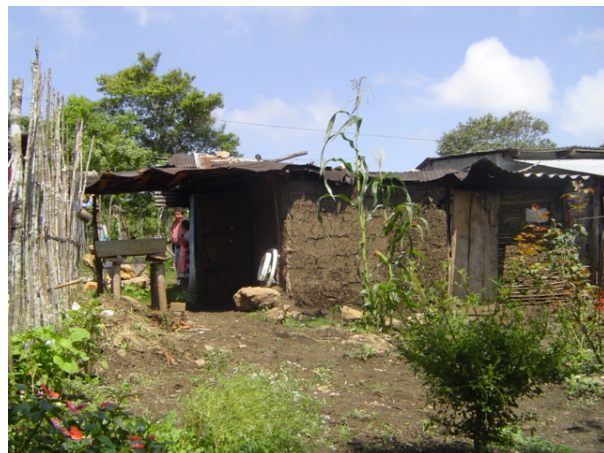
Foto 34; Parte posterior de la vivienda.
