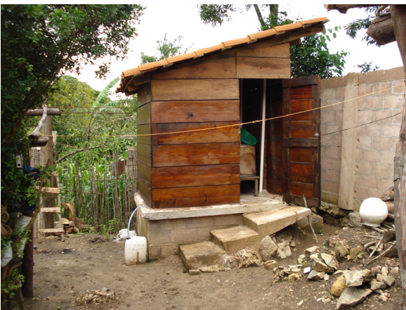
Foto 51; Letrina seca impermeable de 2 cámaras
