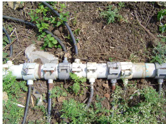
Foto 10; Conexiones múltiples de tomas domiciliarias
