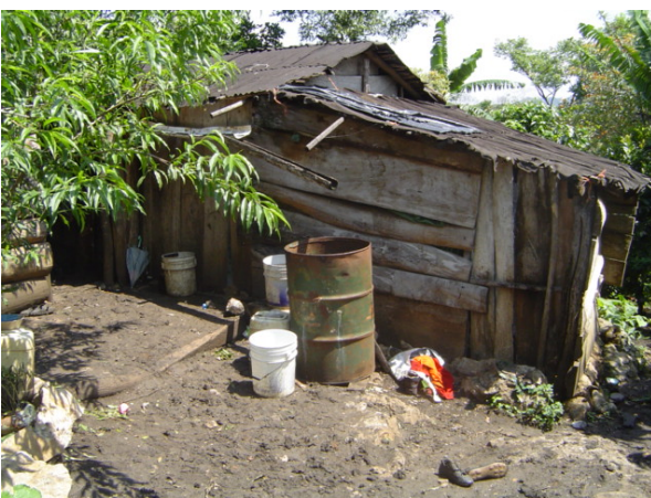
Foto 19; Parte posterior de la vivienda
