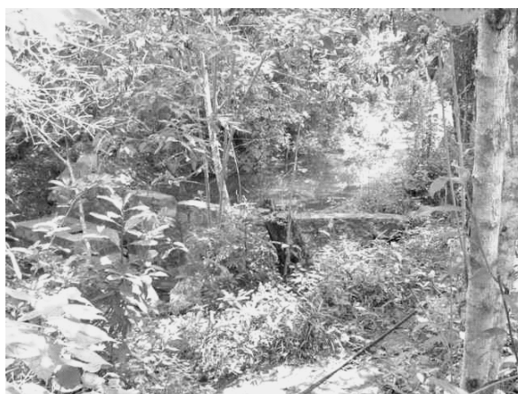
Foto 4; Muro de contención para captación de agua por gravedad en el arroyo “Paso Coyol”.
