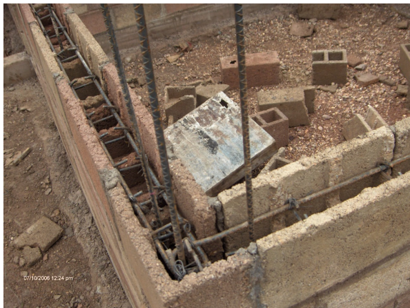
Foto 58; Colocación de refuerzo horizontal interior
