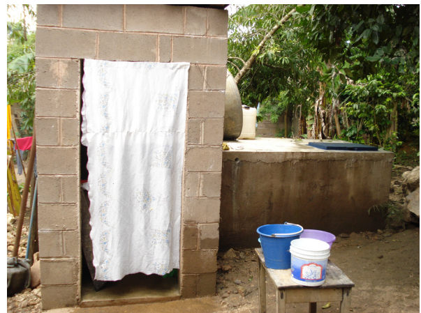
Foto 40; Área de aseo y tanque mejorado
