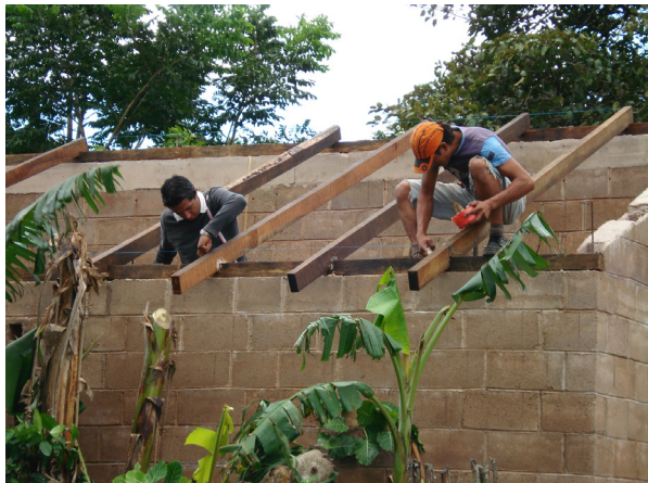
Foto 64; Colocación de estructura de madera en el techo. El señor Joaquín asesorado por el estudiante Bernardo.
