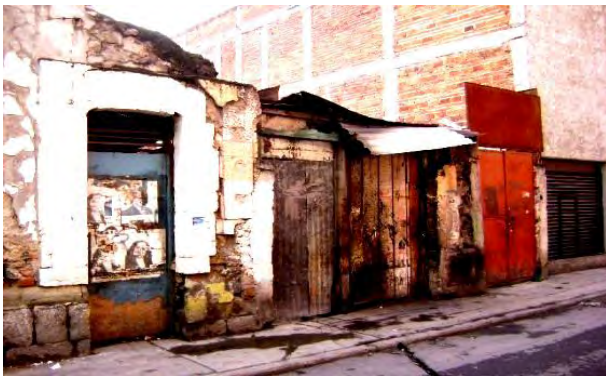
•Fachada principal del predio 7 190. Vista sobre la calle 2 de abril/Colonia Guerrero. Imagén: Javier Angel Santamaria Cruz-Julio César Vilchis Muñoz © 2010.
