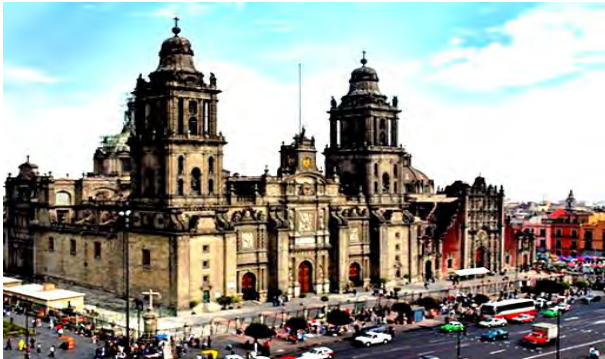
•Catedral metropolitana (1534) 04. Vista panorámica sur-poniente. Imagen: google © 2010.
