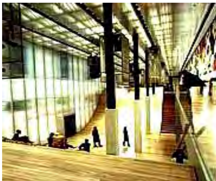
•Interior de tienda PRADA 221 . Rampa de madera (Estructura) / Columnas de acero recubiertas por concreto (elementos verticales). Imagen: google © 2010
