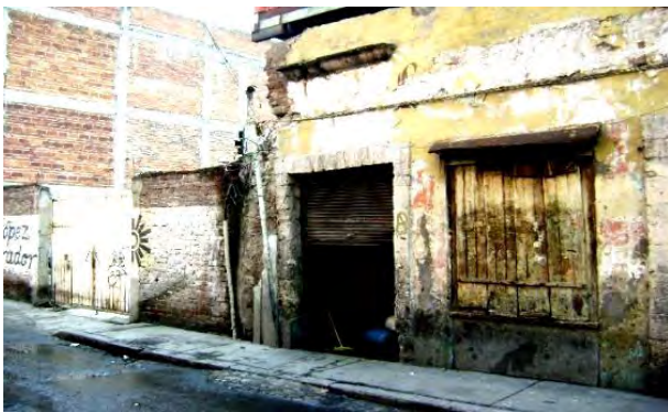
•Fachada principal del predio 8 191. Vista sobre la calle 2 de abril/Colonia Guerrero. Imagén: Javier Angel Santamaria Cruz-Julio César Vilchis Muñoz © 2010.
