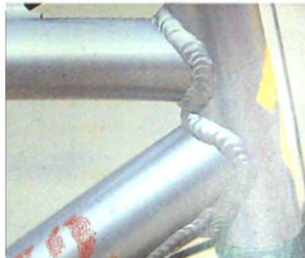
Unión por soldadura TIG
