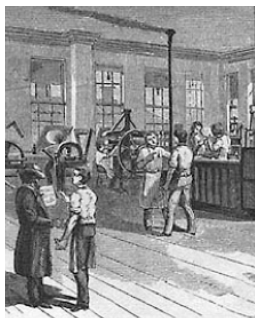
Sala de transferencia.
