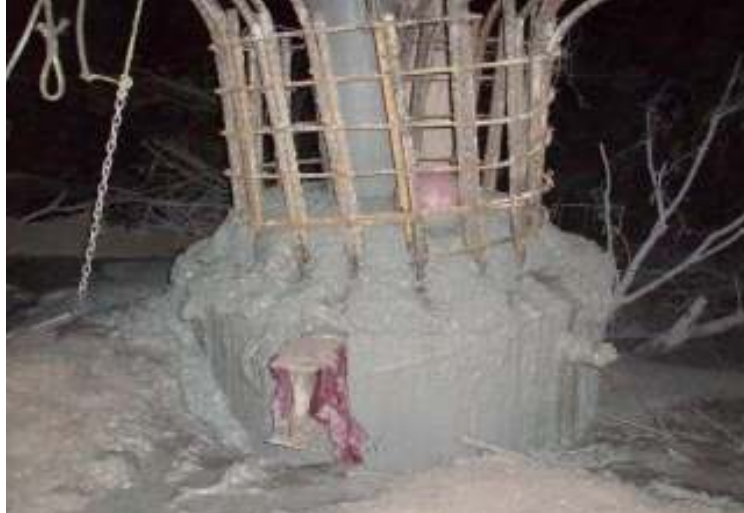
Terminación de colado con concreto sano
