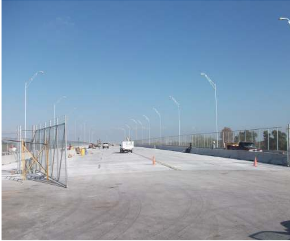
FOTOS DEL PUENTE TERMINADO.
