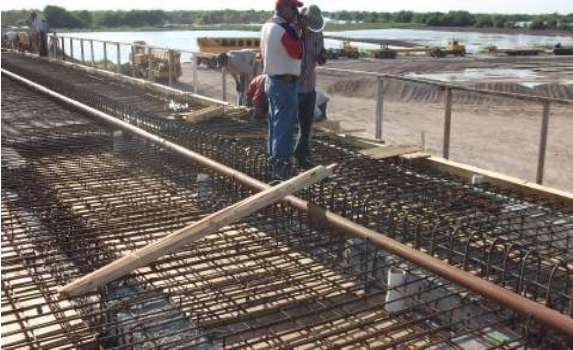
ARMADO DE LOSAS COLADAS EN SITIO COLADAS CON CONCRETO PREMEZCLADO.
