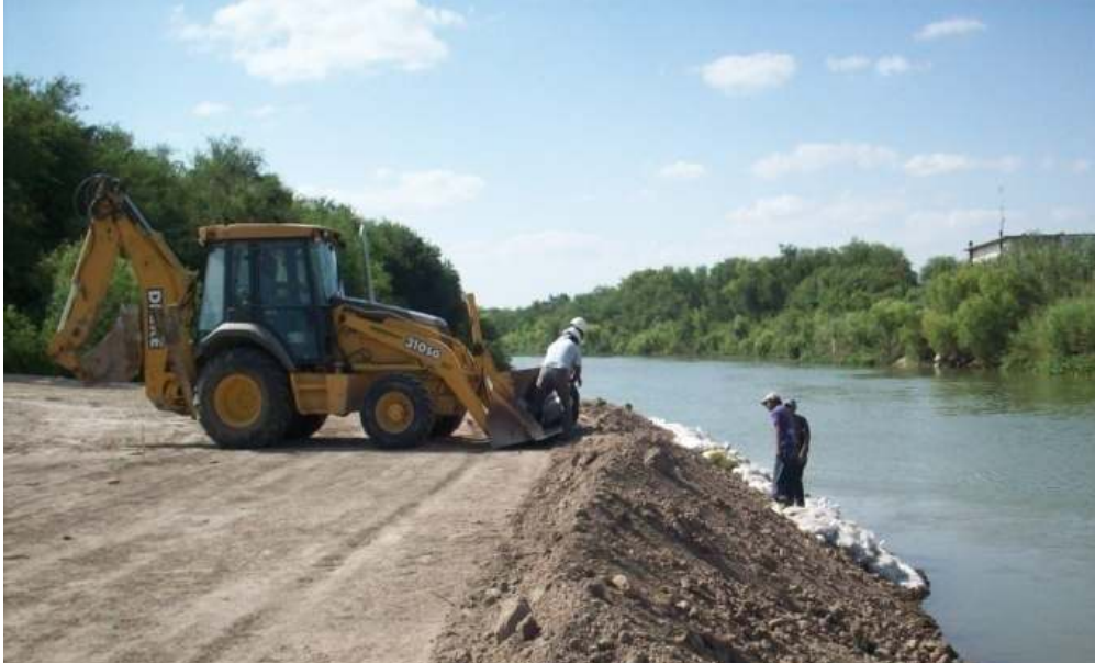
Protección con costales el talud de la Plataforma.
