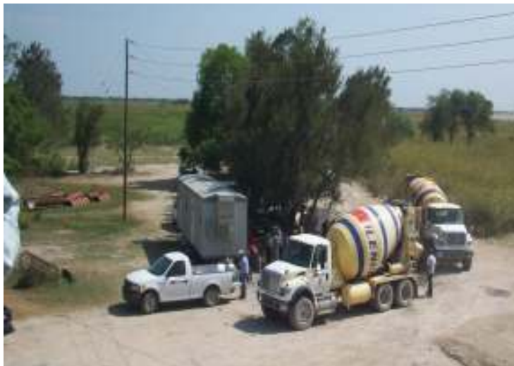
Concreto llegando a la obra
