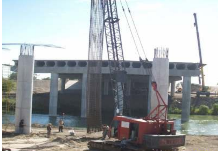
Izaje de armado de acero mediante grúa
