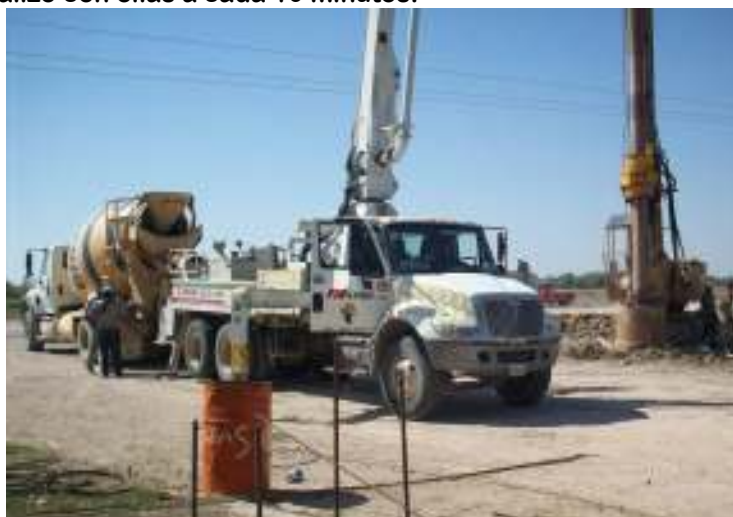
Suministro de concreto mediante bomba
