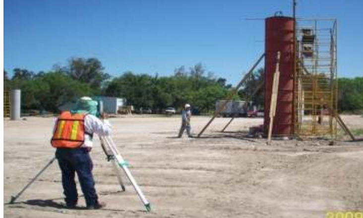
Plomeado de la columna
