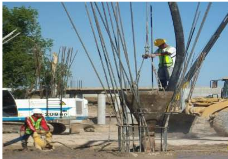
Izado, colado de pilote y extracción de lodo bentonítico
