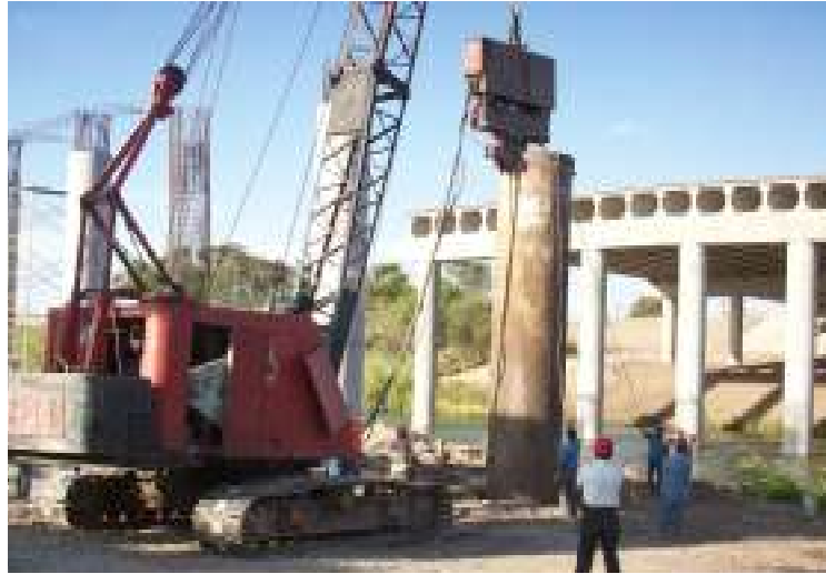
Extracción del ademe con vibrohincador
