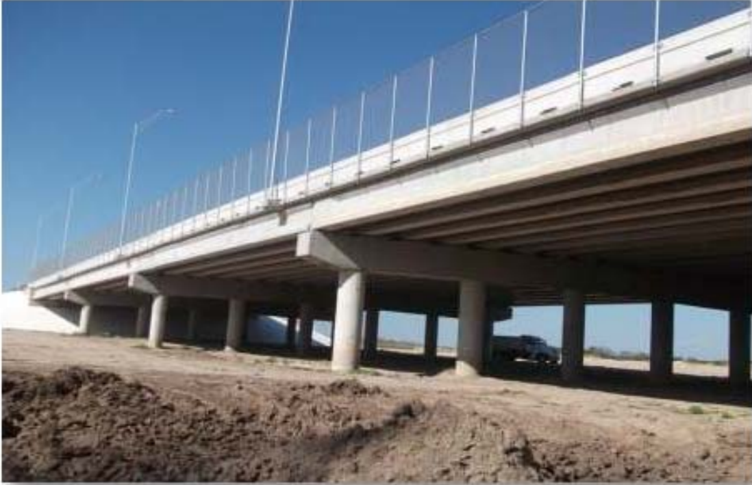
VISTA LATERAL DEL PUENTE TERMINADO
