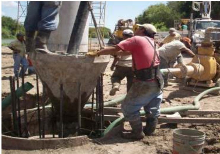
Colada de pilote
