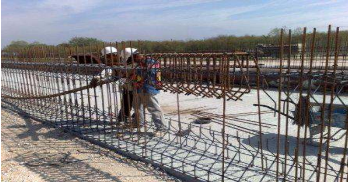
ARMADO DE TRABES
