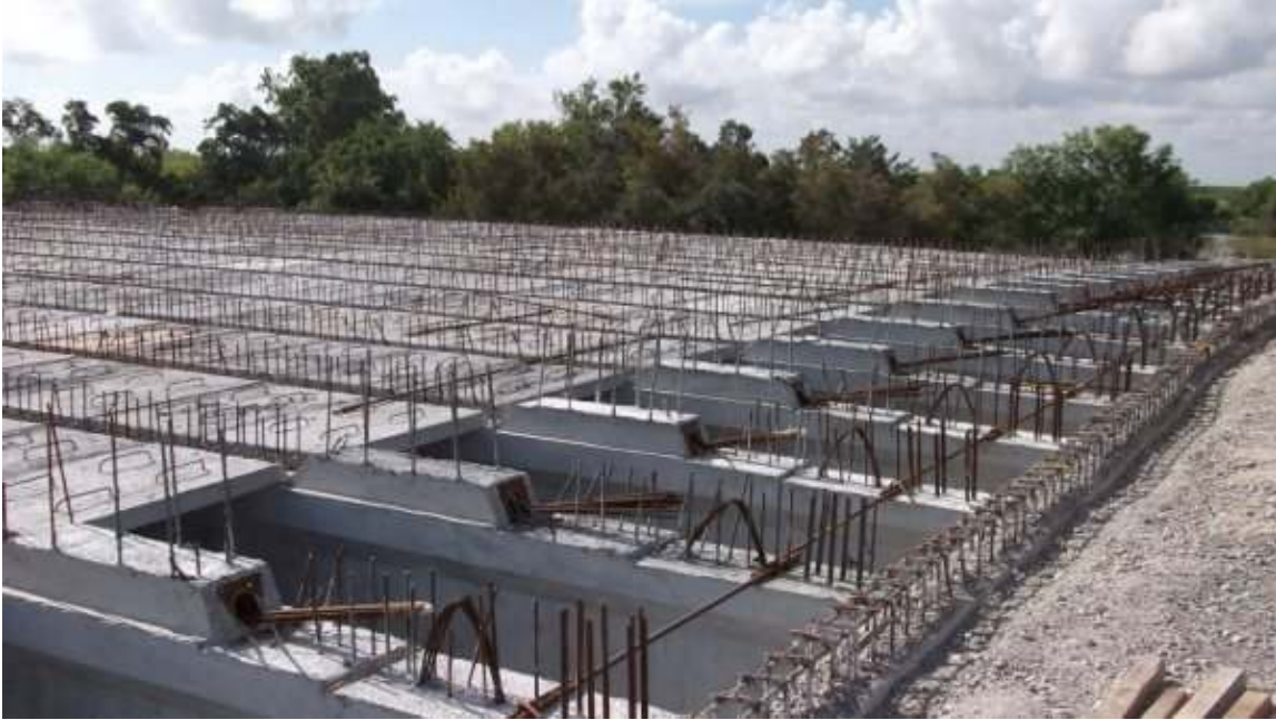
Trabes colocadas en su sitio con la losa precolada, se observan los torones de postensado.
