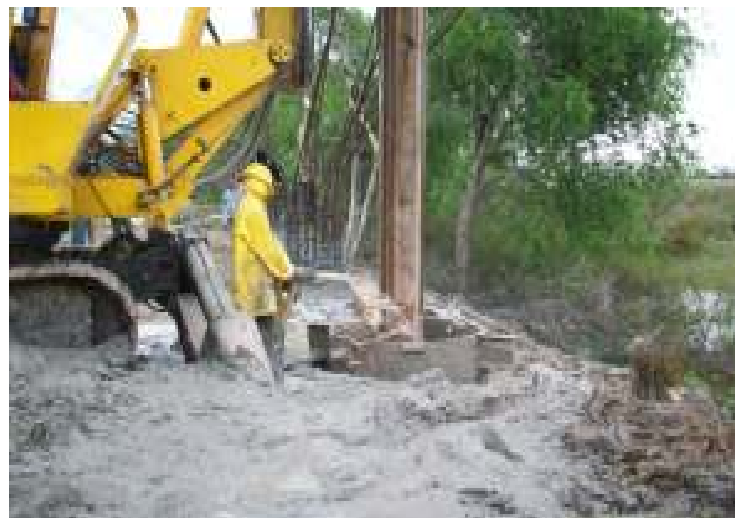
Perforación con incrustación de ademe
