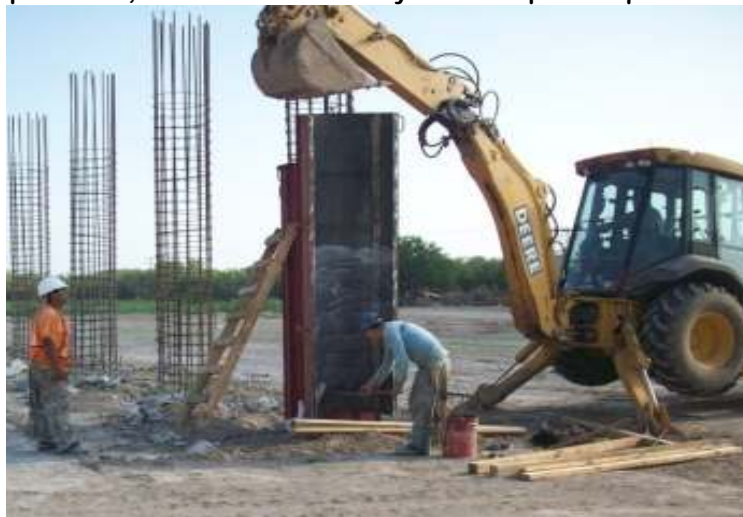
Colocación de desmoldante
