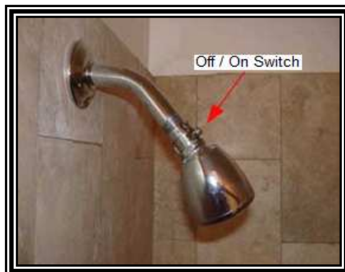
Figura 2.28 Regadera con interruptor de bloqueo (Vargas, 2004)
