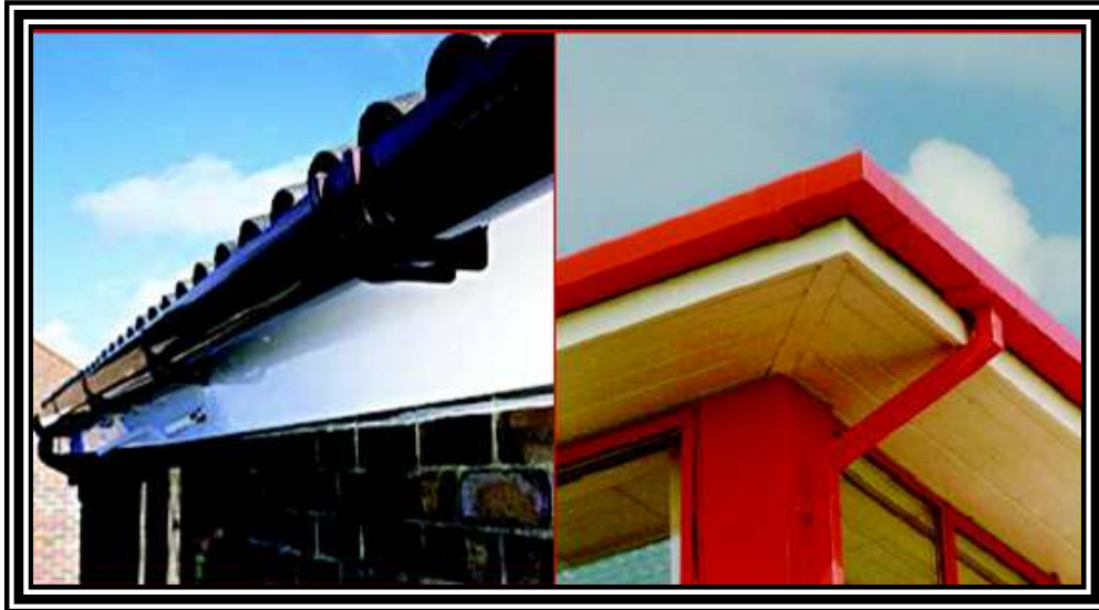
Figura 2.15 Canaletas de recolección (Phillips, 2008)
