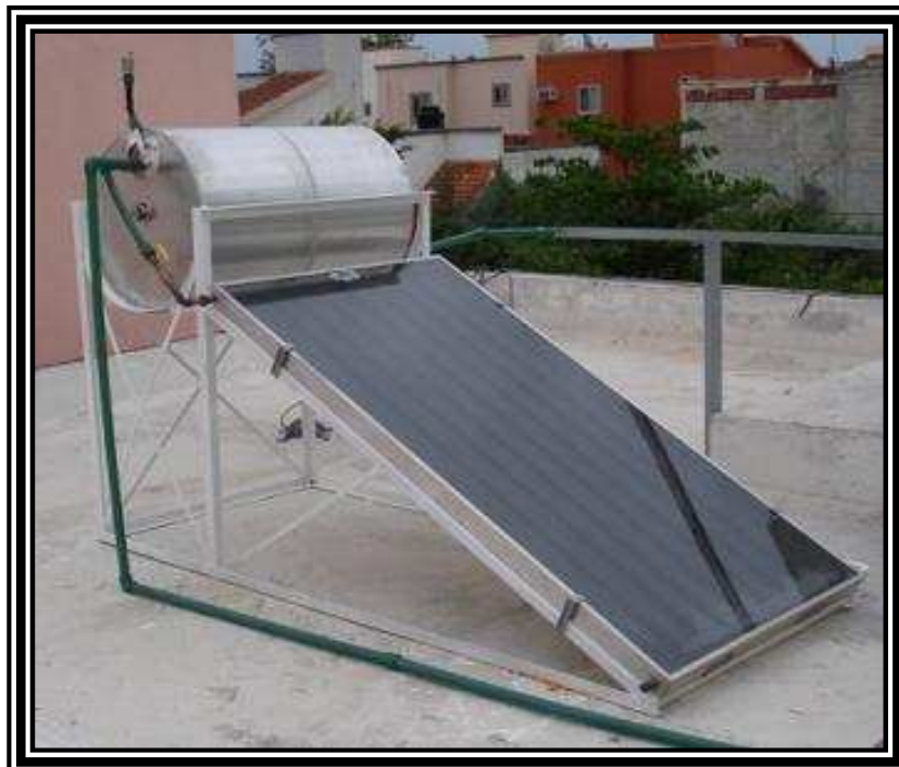
Figura 2.46 Sistema de almacenamiento de agua caliente (IES, 1998)
