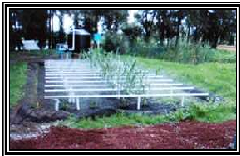
Figura 2.38 Sistema de humedal artificial en Canadá (Miglio, 2006)
