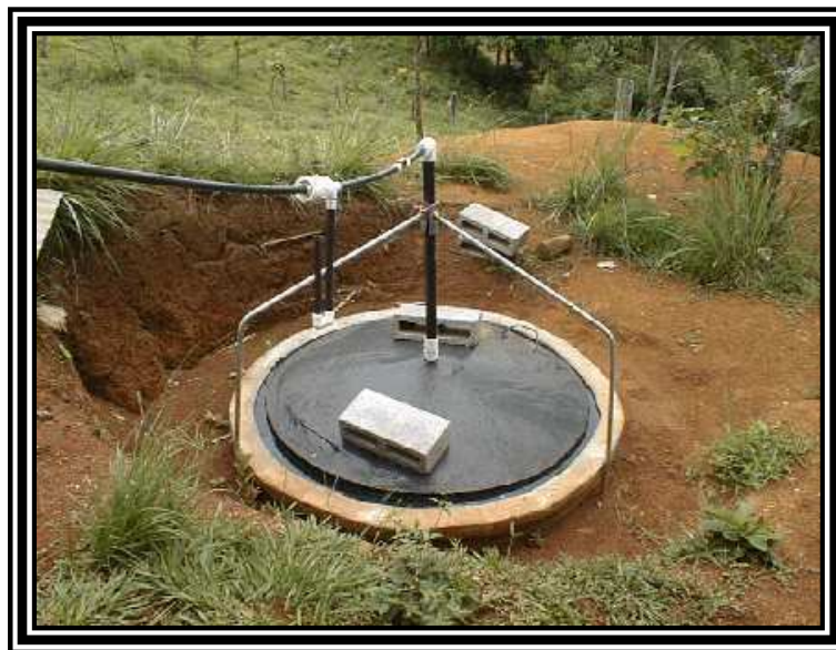
Figura 2.53 Sistema de reactor anaerobio (Martí, 2007)
