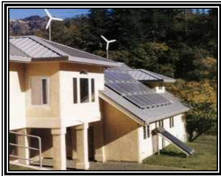
Figura 2.47 Sistema de generación de energía eólica instalado en una casa (Ando y col., 2005)
