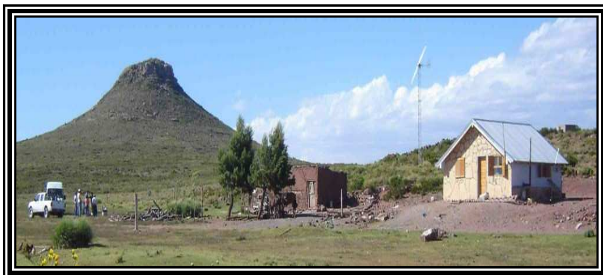
Figura 2.49 Sistema de generación de energía eólica instalado en la Patagonia, Argentina (De Nápoli, 2006)
