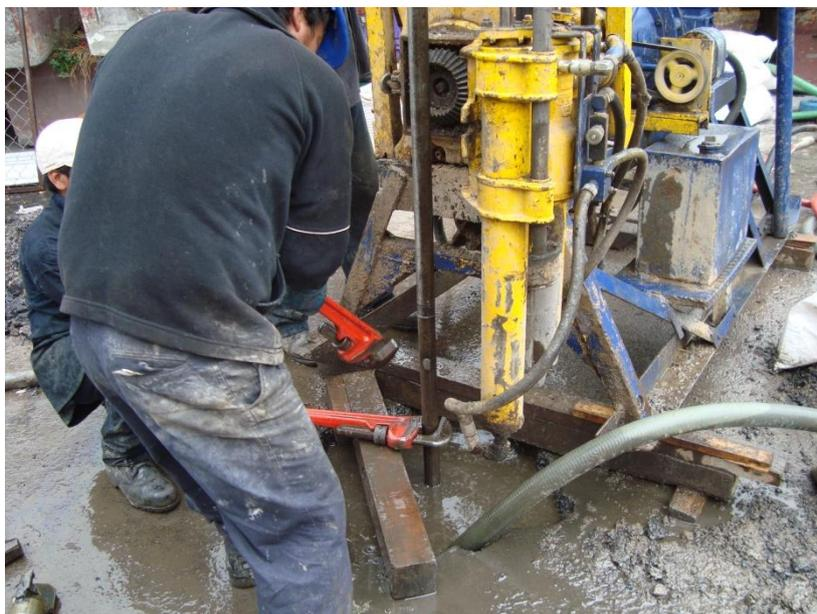
**Figura 61.** Perforación de barreno para instalación de inclinómetro.
