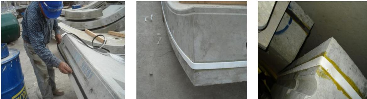
**Figura 7.** Colocación de sellos en dovelas.
