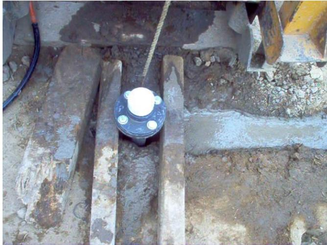
**Figura 68.** Extensómetro de barras previo a la inyección de lodo fraguante.
