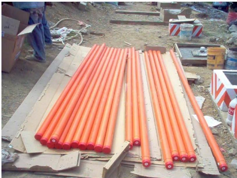
**Figura 62.** Vista de tubería para inclinómetro.
