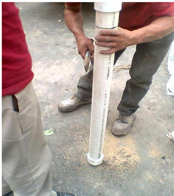
**Figura 28.** Bulbo poroso de Piezómetro abierto.
