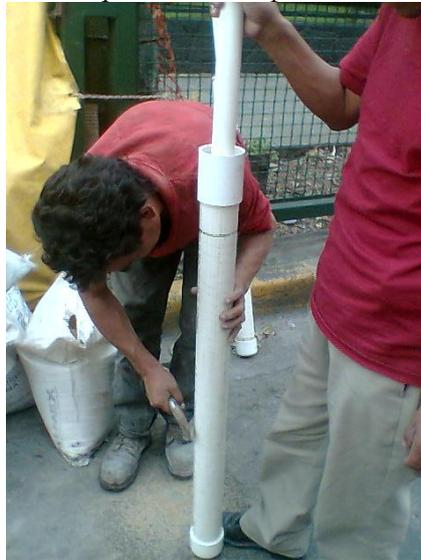
**Figura 75.** Preparación de bulbo para piezómetro abierto.
