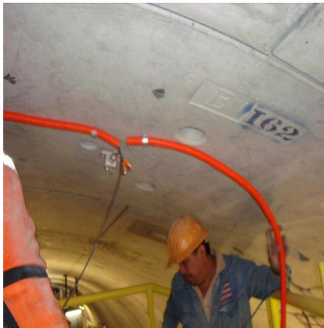
**Figura 56.** Colocación de cables de comunicación entre clinómetros.
