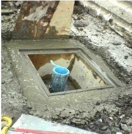
**Figura 63.** Registro de Inclinómetro.
