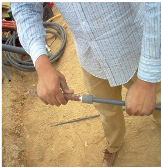
**Figura 64.** Unión de ancla y barra de acero inoxidable.
