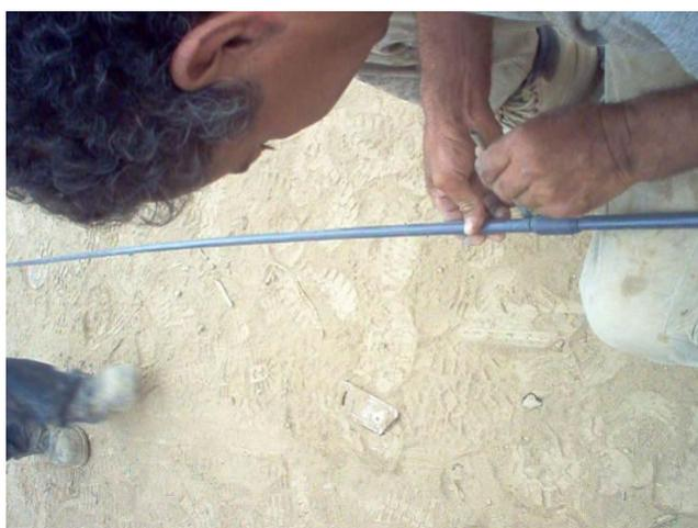
**Figura 65.** Colocación de recubrimiento en barras de acero inoxidable.
