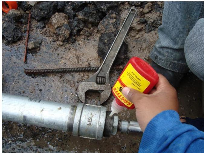
**Figura 83.**Habilitado de la tubería para Piezo-celda.
