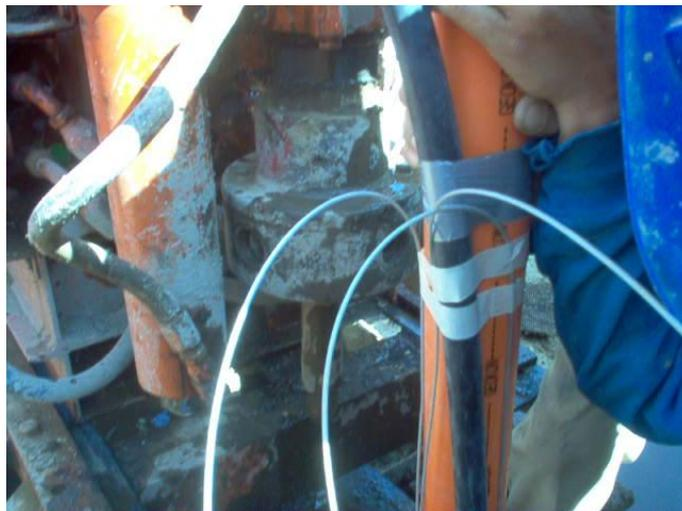
**Figura 73.** Vista de poliducto de inyección y cables de acero adosados en tubería ABS.
