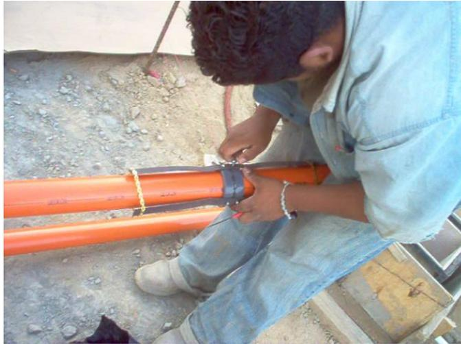
**Figura 72.** Colocación de arañas magnéticas.
