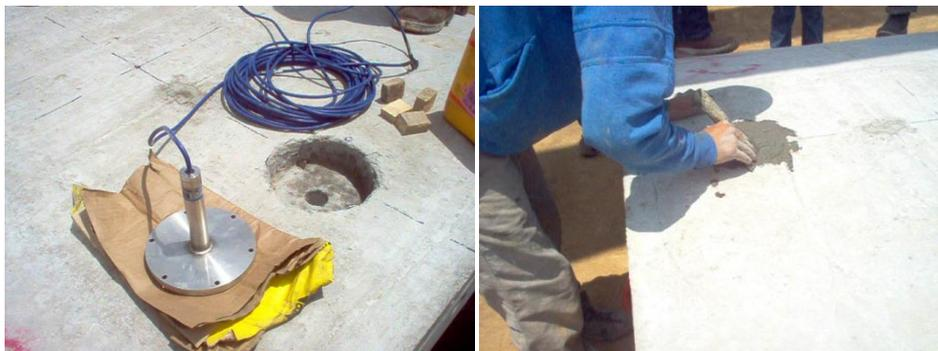
**Figura 40.** Colocación y fijación de celdas en dovela.
