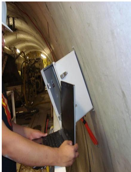
**Figura 58.** Programación de sistema de convergencia y divergencia.
