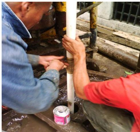
**Figura 76.** Acoplamiento de tubería para piezómetro.
