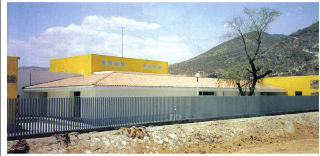
Fachada lateral. Edificio de Consulta Externa.
