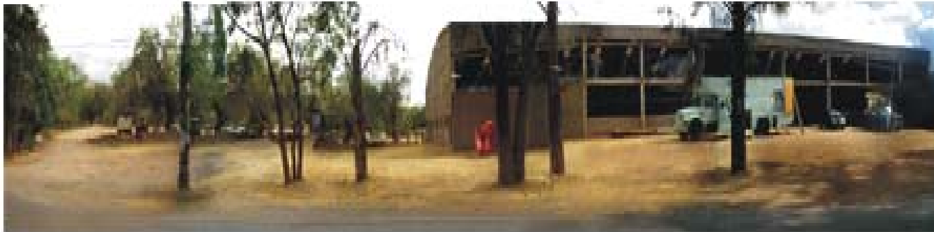
2. VISTA NORTE-SUR. Auditorio Municipal.
