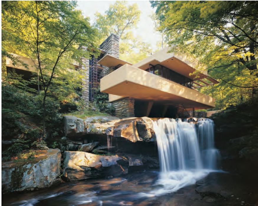
Casa de la Cascada, utilizando terrazas y cuerpos geométricos.
