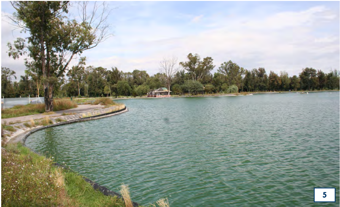
Lado oeste del terreno, muestra falta de mantenimiento.
