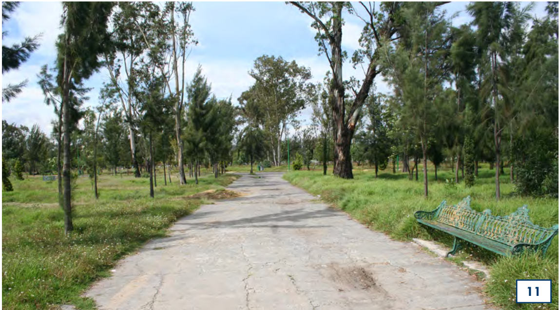
Camino de acceso al terreno del Restaurante entre las circulaciones, no se encuentra en buen estado por falta de mantenimiento.
