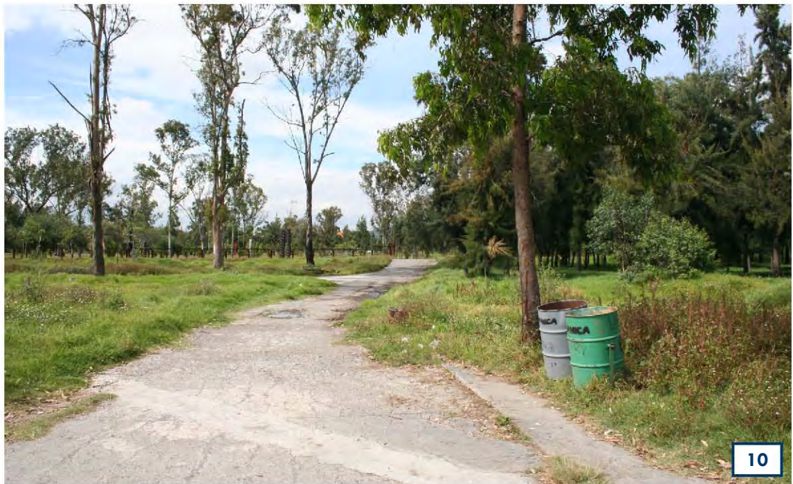
Camino de acceso al terreno del Restaurante, no se encuentra en buen estado por falta de mantenimiento.
