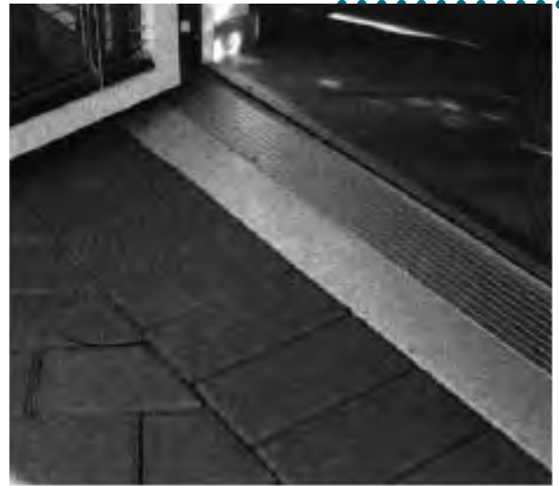
Rampa de suave pendiente que supera el pequeño escalón entre interior y exterior del edificio
