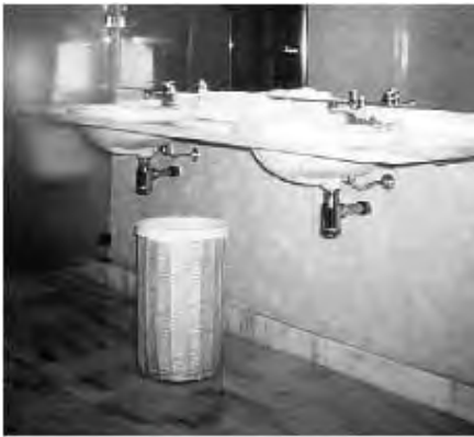
Lavabo sin pedestal, grifería tipo monomando y espejo grande. Apto para P.M.R. y para todos los usuarios
