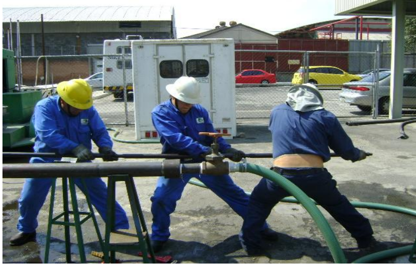
Fig. 4.18. Pruebas de anclaje en tubería de 2 7/8”.
