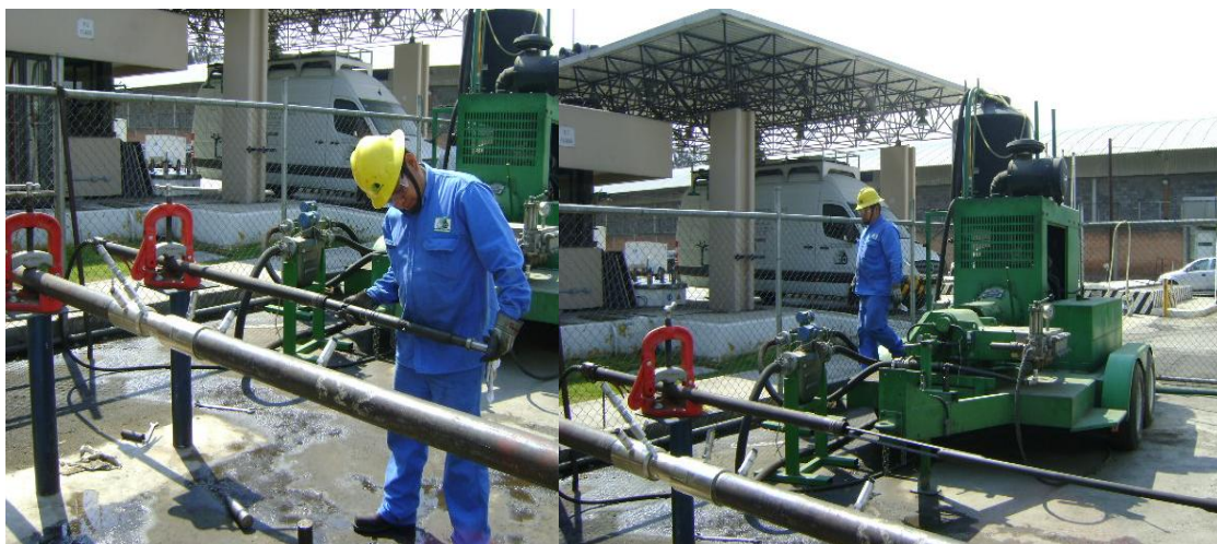
Fig. 4.20. Recuperación de la herramienta con pescante JDC.
