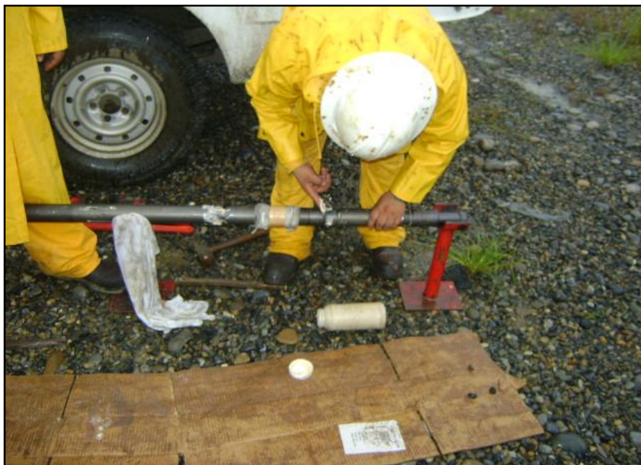
Fig. 4.21. Armado del EDF-Jet en campo, activación de mecanismos, instalación de pernos.
