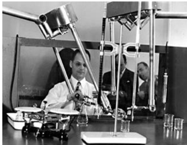
Imagen 10 Raymond Goertz manipulando elementos radioactivos por medio de teleoperacion
