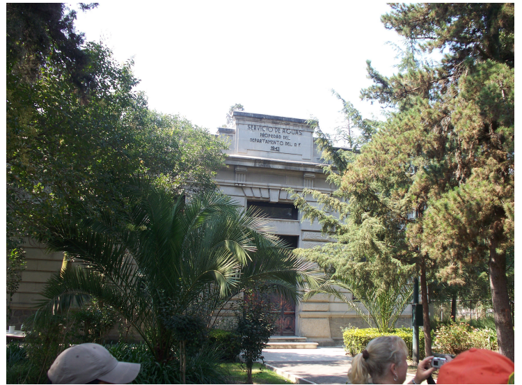
Casa de bombas del Centro de educación ambiental Acuexcomatl.
