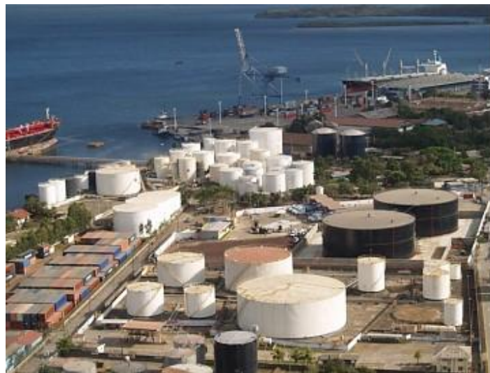
Figura 2.12 Patio de tanques
