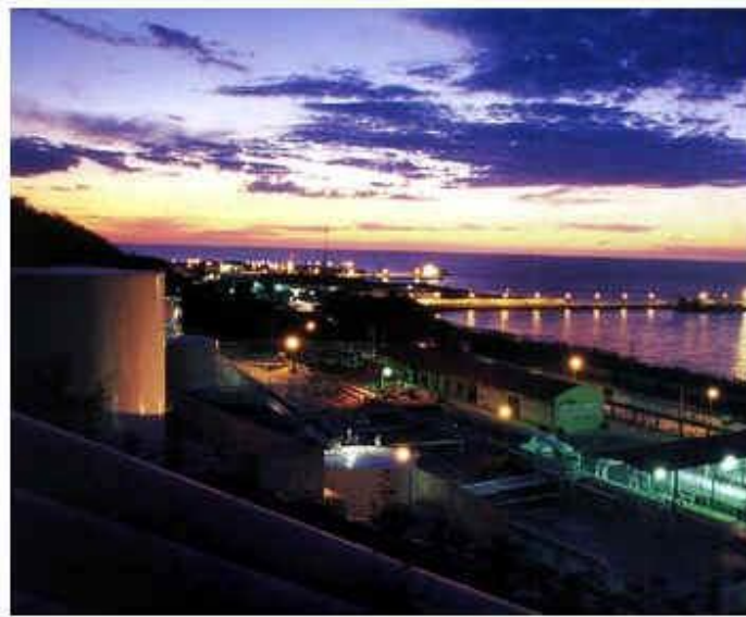
Figura 3.11 Terminal de almacenamiento y distribución en Campeche
