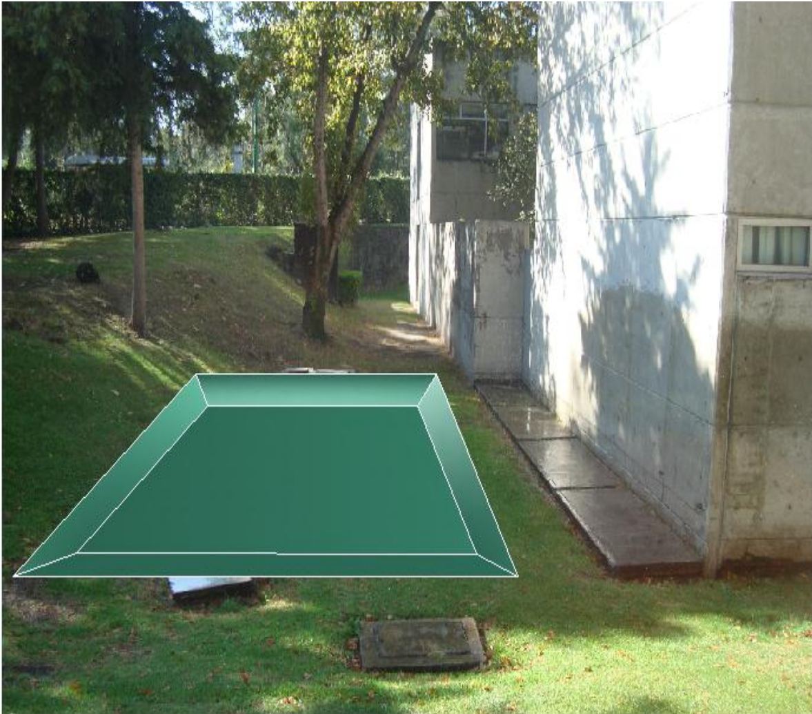
Figura 8.9. Excavación, compactación, nivelación e impermeabilización con geomembrana. Se recomienda excavar 75 cm aproximadamente (10 cm de la capa orgánica, 60 cm de medio- arena-grava y 5 cm de cubierta) además el talud de avance en el frente de la excavación será de 2:1 (vertical: horizontal) por lo que el área superficial tiene que ser de:
