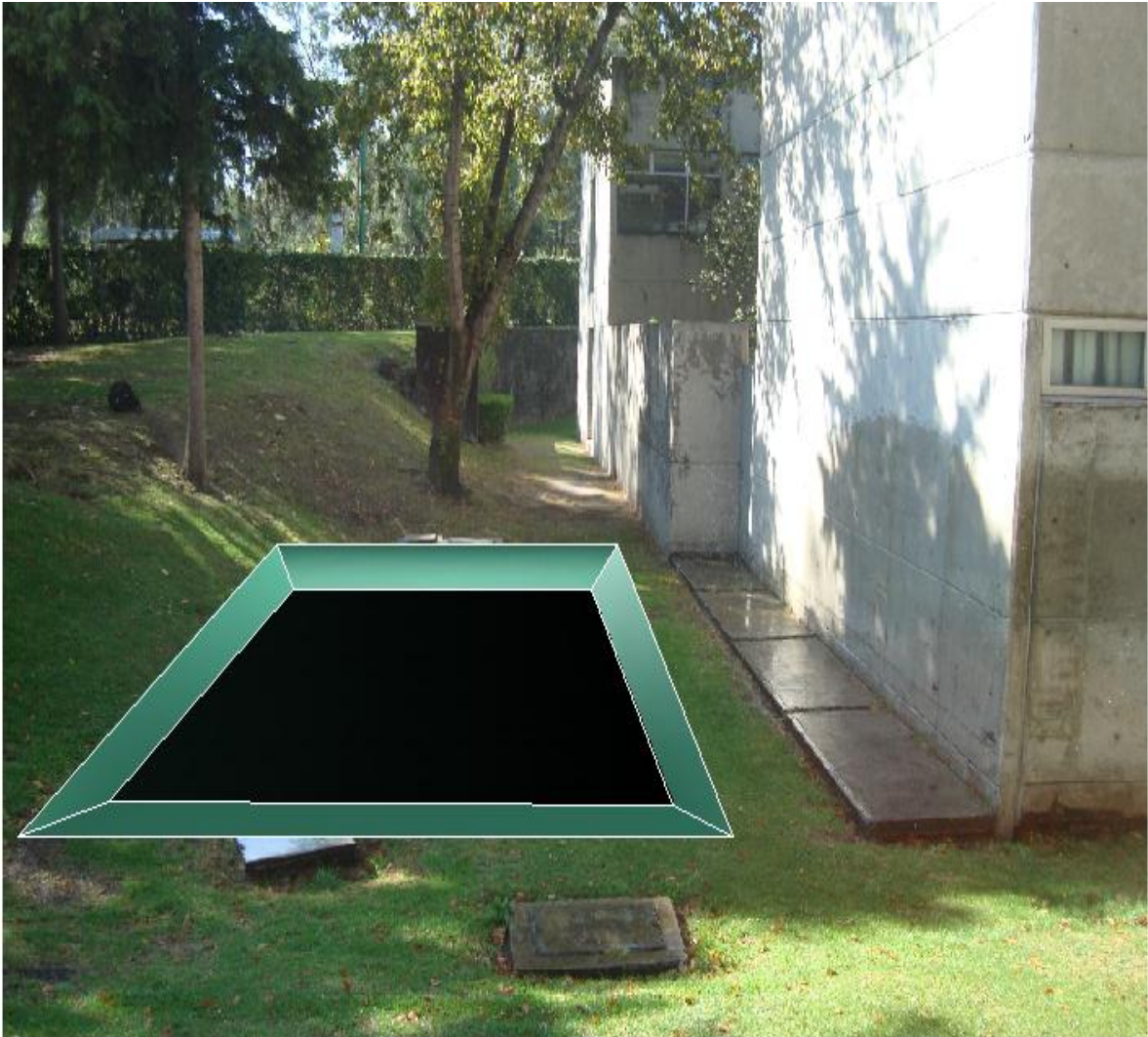
Figura 8.10. Colocación de arena ó capa vegetal (aproximadamente 5-10 cm)
