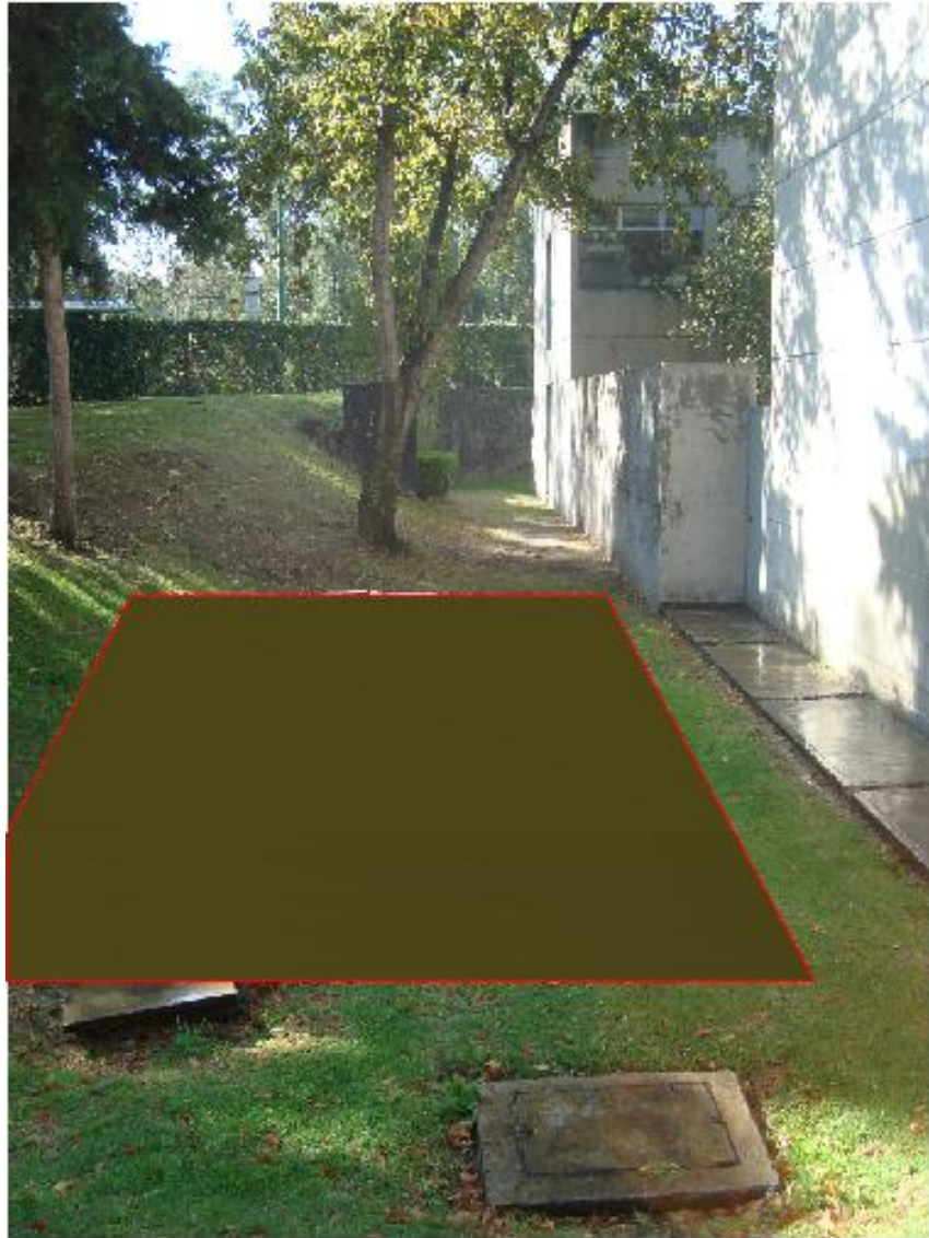
Figura 8.8. Desmonte y despalme
