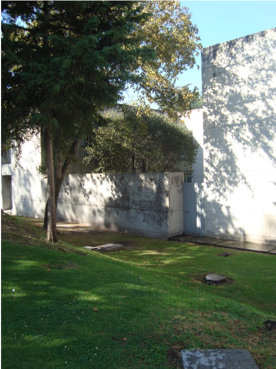
Figura 8.15. Vista panorámica de las estructuras de entrada
