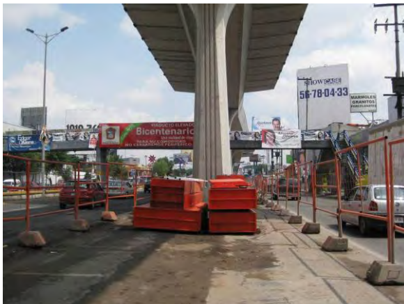
La noche del viernes 12 de junio se colaron los dados de reacción con un concreto de 400 kg/cm 2 con resistencia a 7 días
