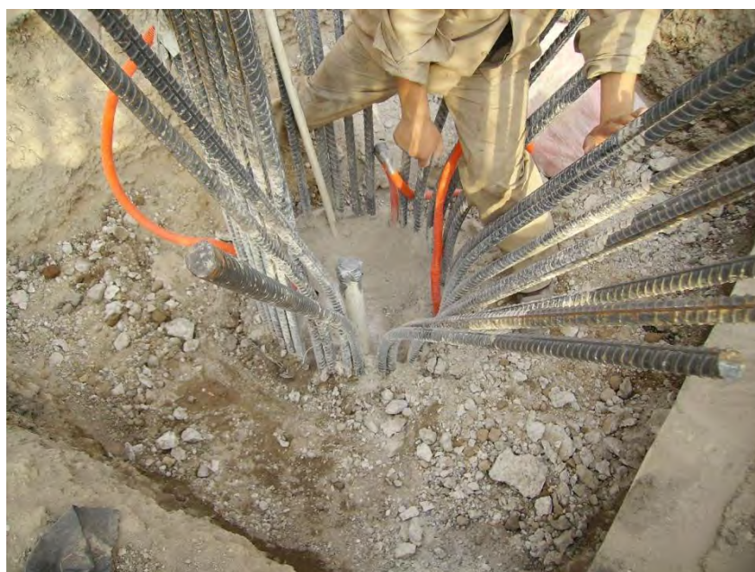
Figura 5.2 Vista de la realización de la prueba de integridad en pila de prueba
