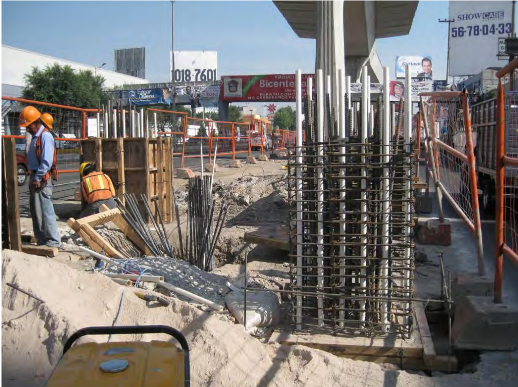
Se montaron los dados de reacción y cabezal de la pila de prueba
