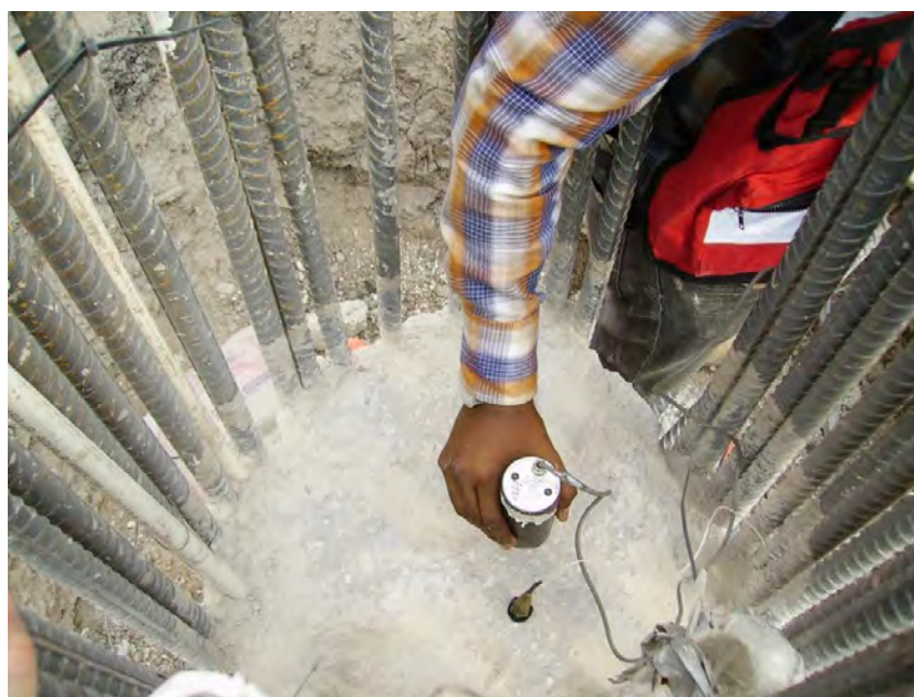
Figura 5.1 Vista de la realización de las pruebas de integridad en pilas de reacción
