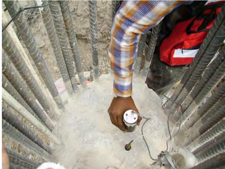
Figura 3.1 Equipo de la prueba de integridad
