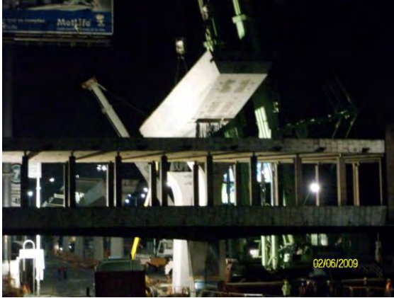
La noche del lunes 1 de Junio de 2009 se colocó la trabe 1 TARE 7 sobre los apoyos A-73 y A-74
