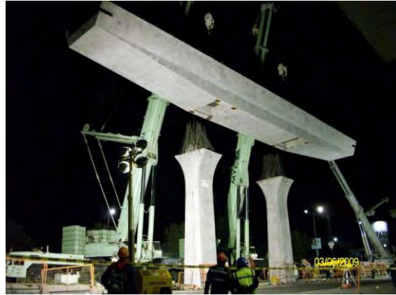
La noche del lunes 1 de Junio de 2009 se colocó la trabe 1 TARE 7 sobre los apoyos A-73 y A-74
