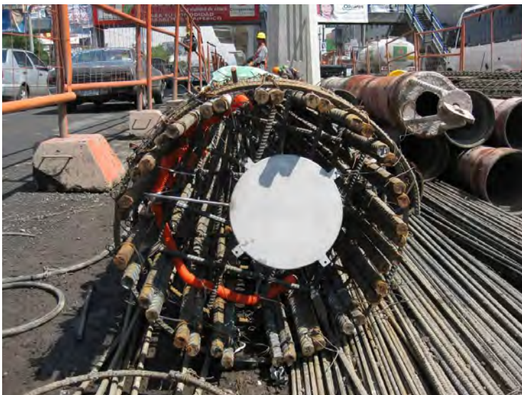
El domingo 24 de mayo de 2009 los técnicos concluyen con la instrumentación de la pila de prueba y queda preparada para su colocación y colado de la pila.
