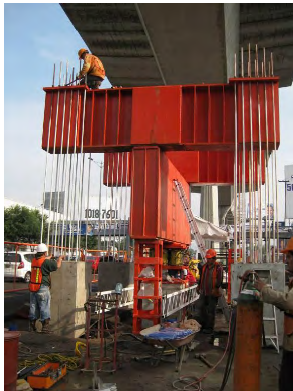
Montaje del sistema de reacción
