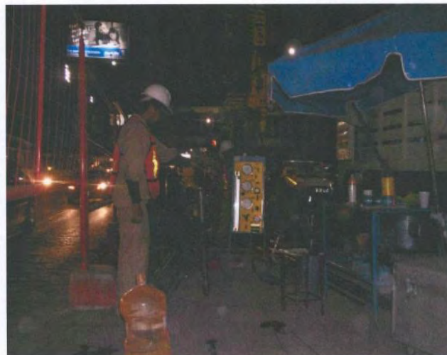
Foto 2 Preparación del equipo para la ejecución de las pruebas
