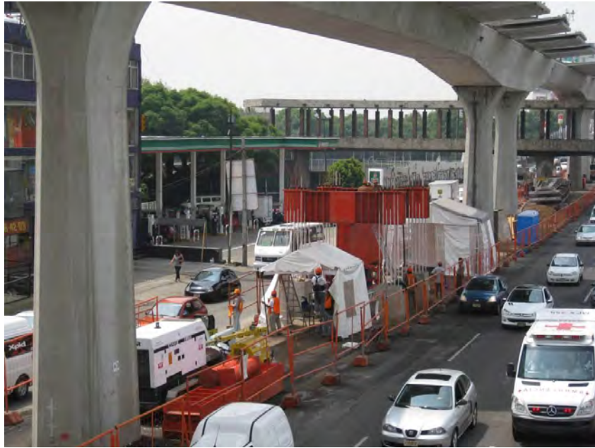
Vista General del sitio donde se ejecutó la prueba
