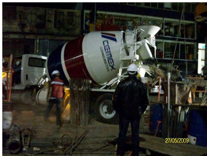
Las ollas de concreto llegaron a las 2:30 hrs, por lo que se comenzó con el vaciado de concreto en la pila.
