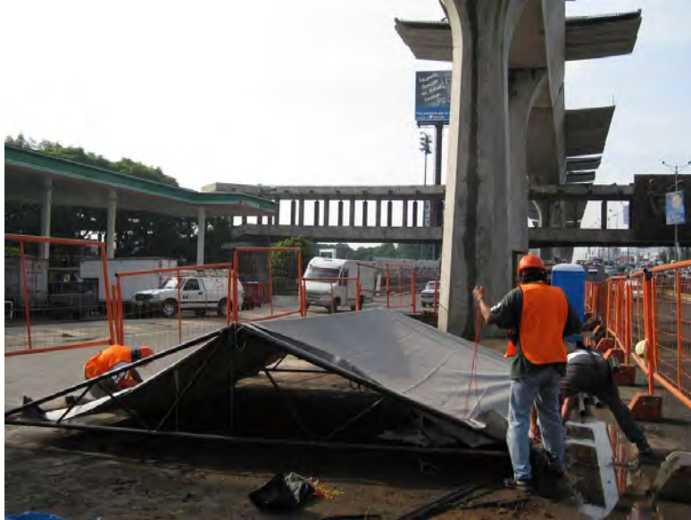
Montaje de una de las carpas
