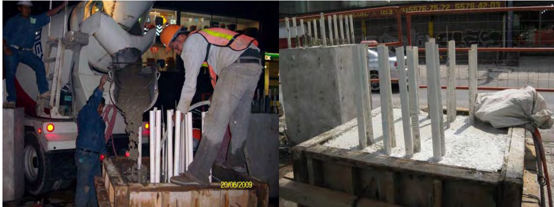
La noche del viernes 12 de junio se colaron los dados de reacción con un concreto de 400 kg/cm 2 con resistencia a 7 días
