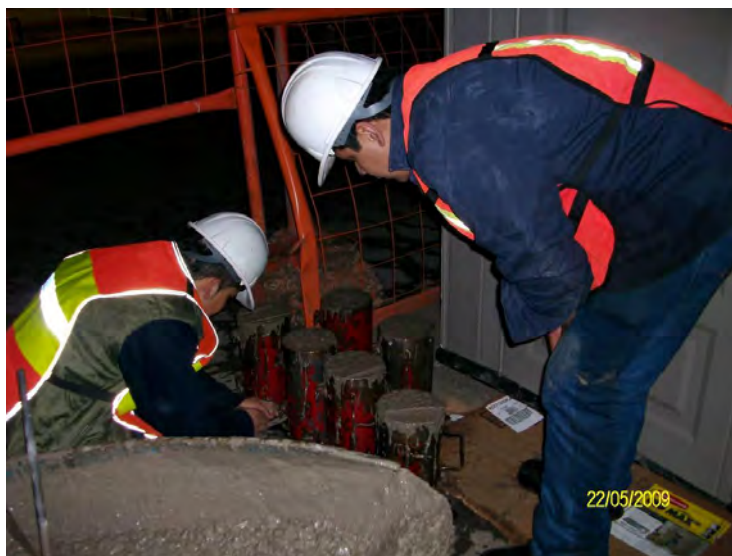
Introducción acero de refuerzo en la perforación, colado de Pila y toma de muestras de concreto
