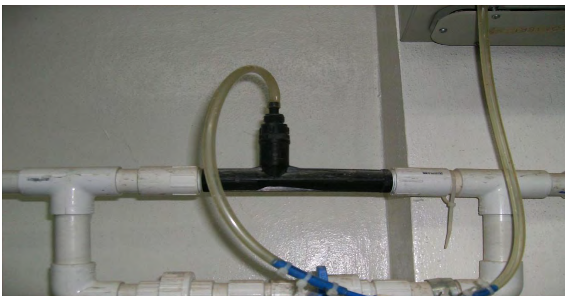
Foto 28. Creado por el inventor italiano Giovanni Battista Venturi, el dispositivo actúa para incorporar el ozono en el agua a partir de una diferencia de presión entre el lugar donde entra la corriente y el punto de mínima sección del tubo.
