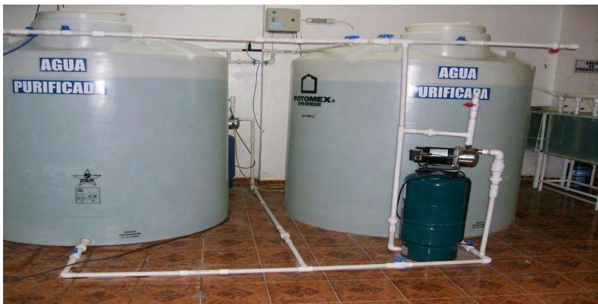
Foto 29. Imagen captada en la planta purificadora Bio Light , apréciase la ubicación del generador de ozono con el tubo de Venturi al fondo y la disposición del sistema de recirculación del O 3 al ser introducido a los tinacos que contienen el agua purificada.
