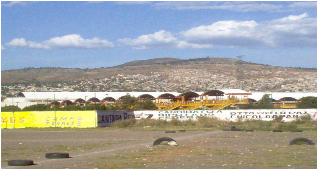
Foto 15. El 12 de agosto de 1991 se inaugura la estación del metro la Paz construida en el predio del Arenal, al fondo se puede apreciar la colonia Ejidal el Pino y los asentamientos irregulares que se originaron en su entorno.
