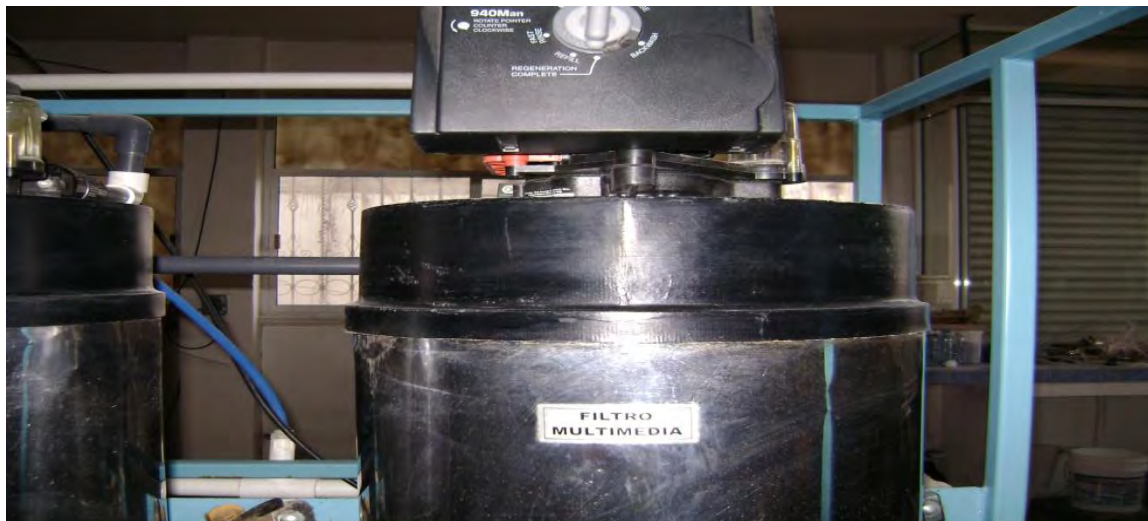
Foto 20. El filtro multimedia es conocido, también, como filtro de presión en cuyo interior el agua fluye a través de capas de arena, no utiliza la fuerza de la gravedad, el agua se bombea a presión sobre la capa granular.
