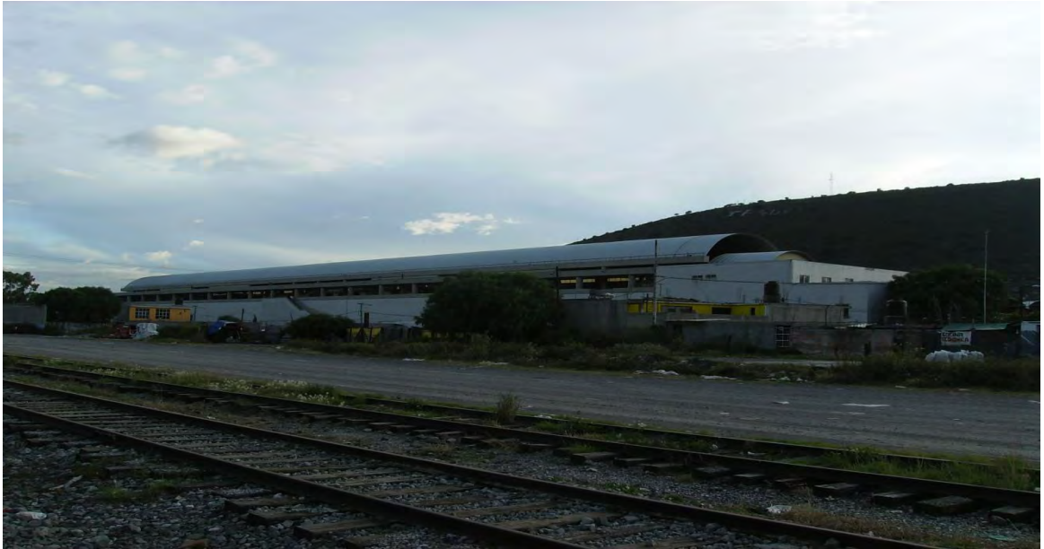
Foto 11. Vista de las vías del ferrocarril de la estación los Reyes, y la línea "A" de la estación del metro férreo La Paz - Pantitlán, ambos construidos en el predio denominado el arenal, y que en la actualidad ha representado un problema para la recarga de los mantos acuíferos del Municipio.
