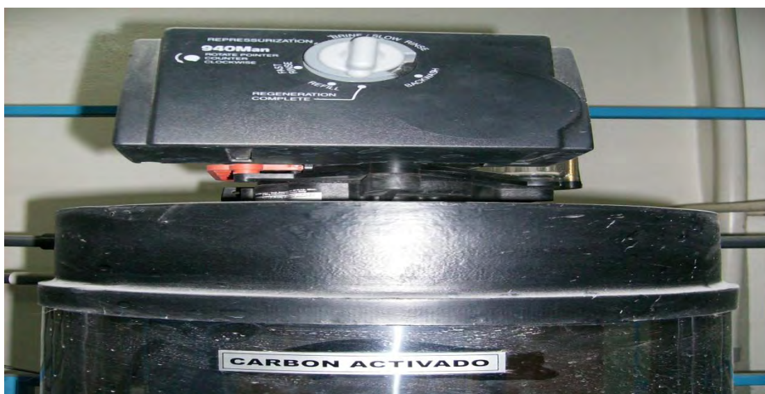
Foto 21. Cilindro metálico que contiene el carbón activo elimina el olor a huevo podrido, el sabor metálico, el sabor ligeramente salado y el sabor a cloro, el olor a pescado y el olor a aceite.
