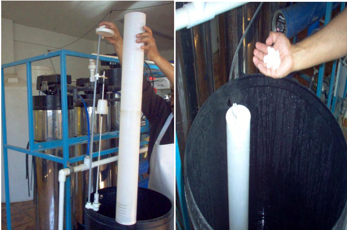
Foto 23. Dos aspectos del intercambio iónico, en el primero se introducen en el tinaco corto, con agua, el cartucho de intercambio, una vez colocado se le agregan las sales, cubriendo la base del fondo del contenedor con ellas,
