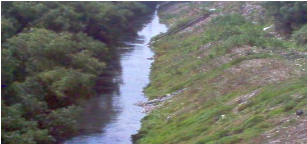
Foto 14. Las descargas residuales de las diversas industrias ubicadas en estos predios han representado un verdadero peligro para la salud de sus habitantes la indiferencia y el olvido se ven manifiestos cuando se arrojan al canal, agua sin ningún tratamiento por parte de la industria, la que poco se ha comprometido para no contaminar el medio ambiente.
