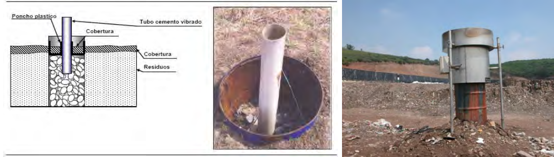
Figura II.15 Instalación de tubo de quema de biogás.
