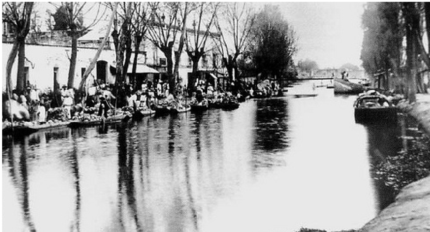
Vista de Calzada de la Viga 1908
