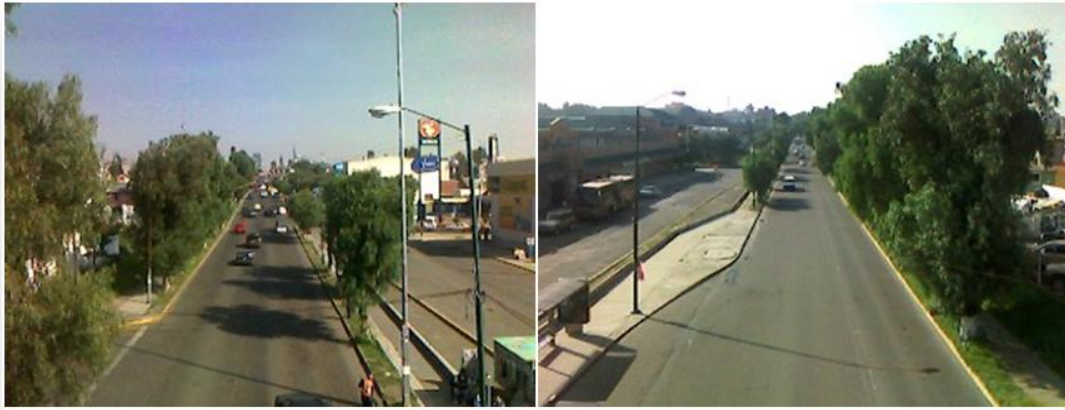
Ilustración 14 fotografías de la avenida 1° de Mayo 71
