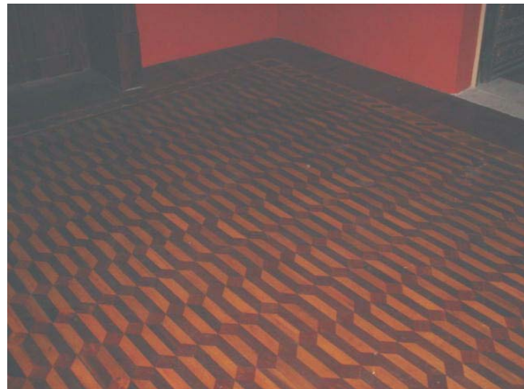
Imagen 37. Vista actual del piso del vestíbulo de la escalera de servicio. 2005
