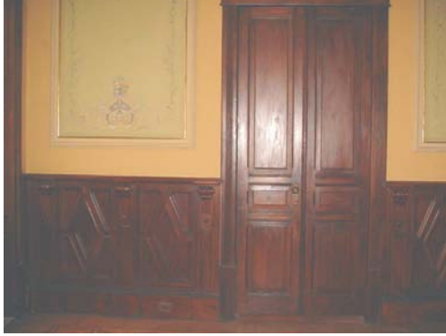
Imagen 39. Vista actual del lambrín del comedor. 2005
