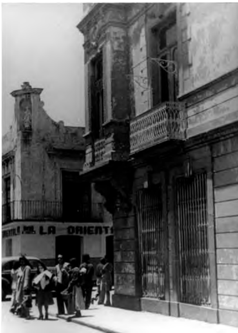
Imagen 10. Desplante del torreón en el segundo nivel. (ca. 1920) Fototeca Juan C. Méndez Gobierno del Estado de Puebla
