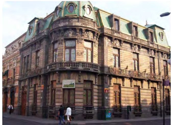
Imagen 5. Casa construida por Carlos Bello y Acedo, ubicada en Av. Reforma No. 725 2005
