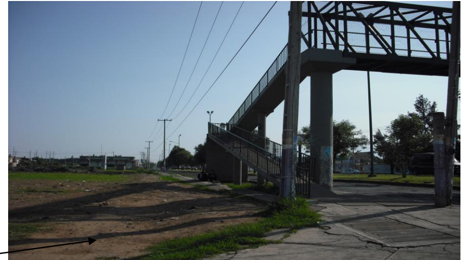
L-26 Puente peatonal en esquina y parada de transporte publico
