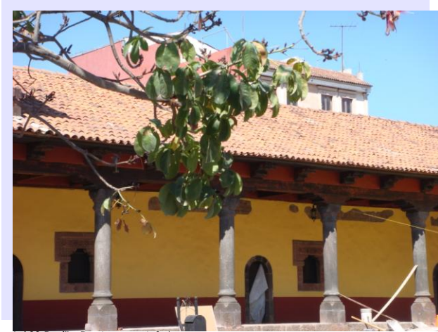
L-138 Pasillo De Acceso A Salones
