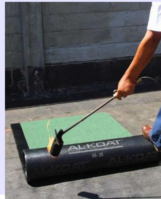
L-355 SISTEMA DE IMPERBEABILIZACION TIPO KOAT
