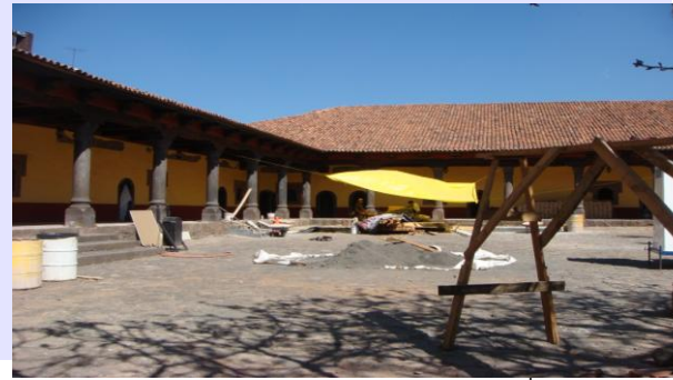
L-139 Patio Interior
