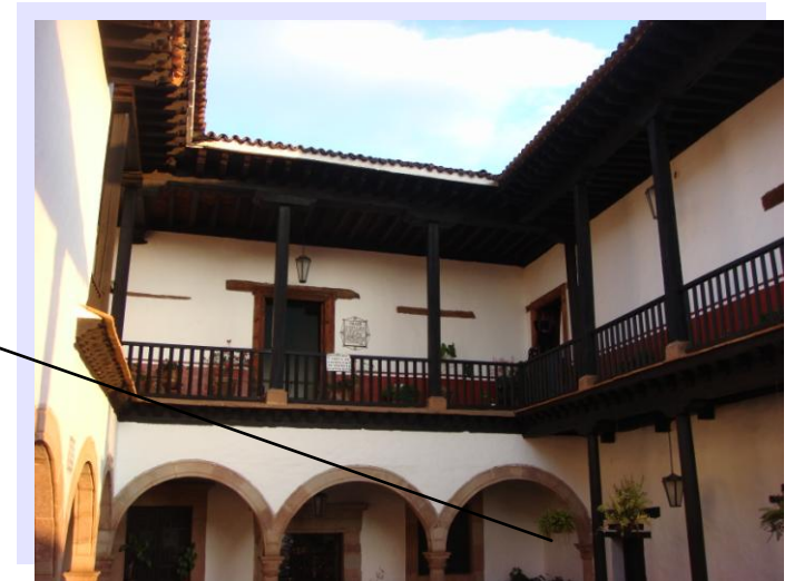
L-144 PATIO INTERIOR CON ARQUERIA Y PASILLOS
