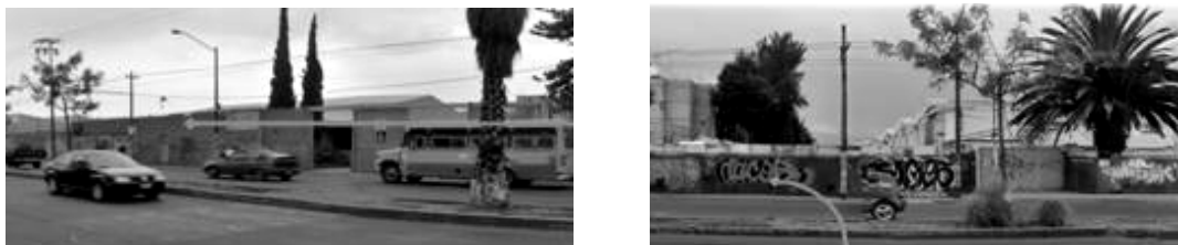
Imagen 64 Acabo en las fachadas y protecciones
