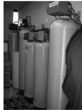
Imagen 18 Tanque Suavizador
