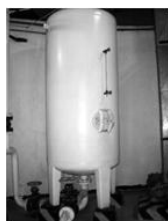
Imagen 29 Hidroneumático Gases Medicinales
