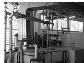
Imagen 34 Ductos de Inyección
