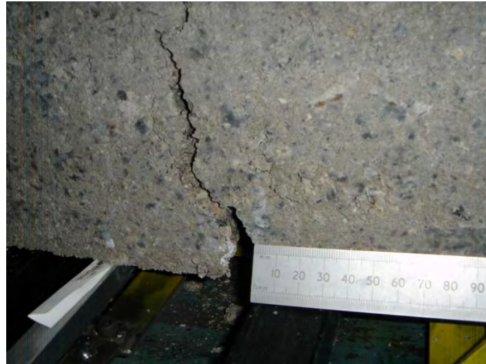
Figura 6.50. Ruptura de una viga sometida a carga cíclica
