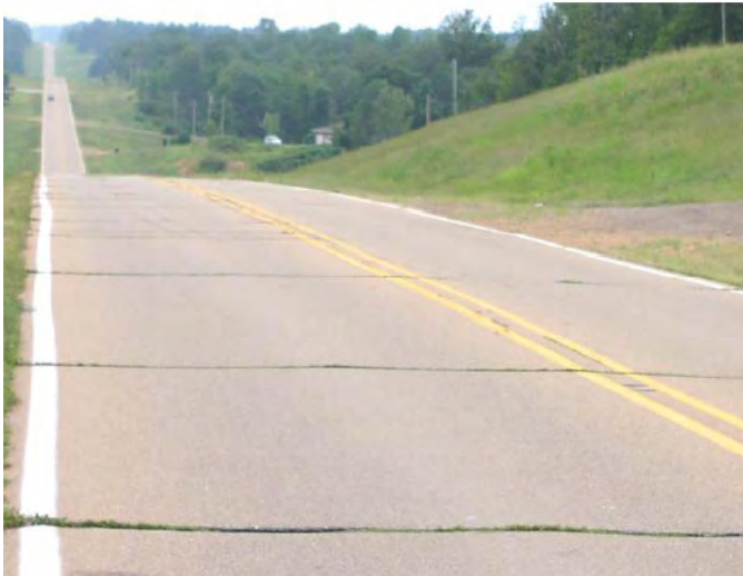
(a) Vista de la superficie de la carretera
