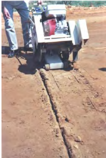
Figura 3.11. Precorte de la base estabilizada (George, 2001)
