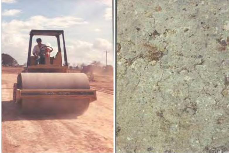
Figura 3.12. Preagrietamiento de una base estabilizada (Scullion, 2002)
