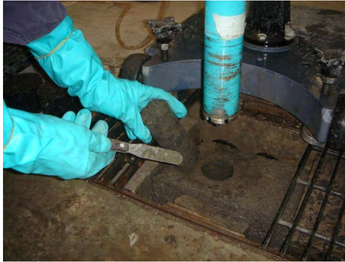
Figura 6.61. Extracción de núcleos procedentes de vigas ensayadas
