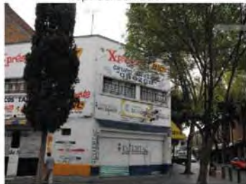
Edificio de comercio que termina en la esquina a 45 grados.
