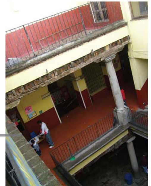
Vista del patio interior. Podemos ver el pórtico que sirve como circulación.
