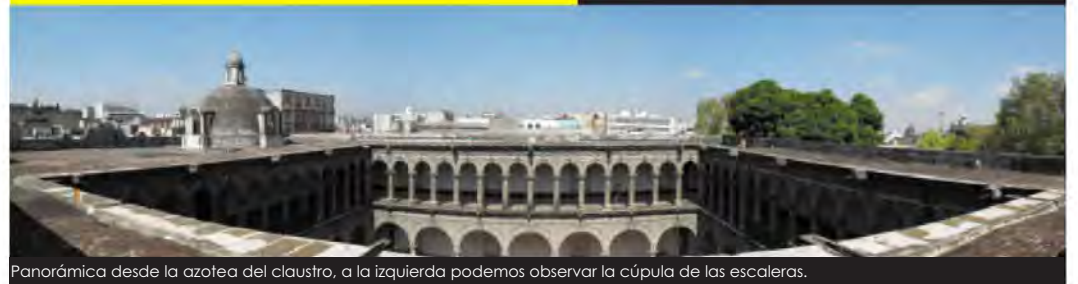
Panorámica desde la azotea del claustro, a la izquierda podemos observar la cúpula de las escaleras.
