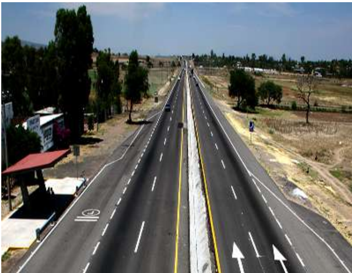
Figura 4.13 Tramo Carretero Irapuato – La Piedad
