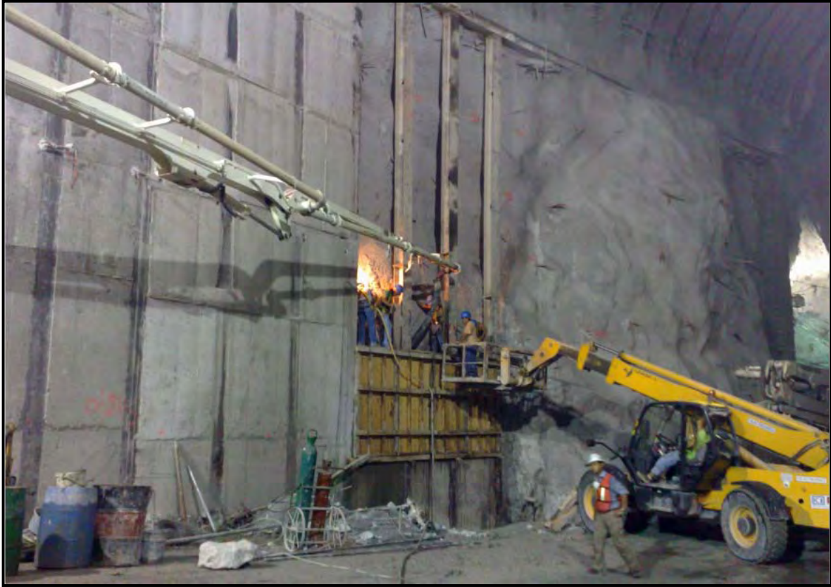
Figura 7.22 Trabajos en la media sección inferior –hastial derecho
