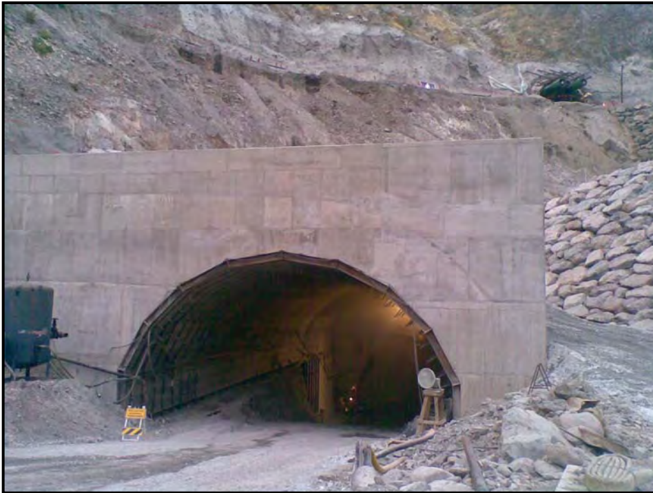
Figura 7.30 Colocación de la media sección inferior.
