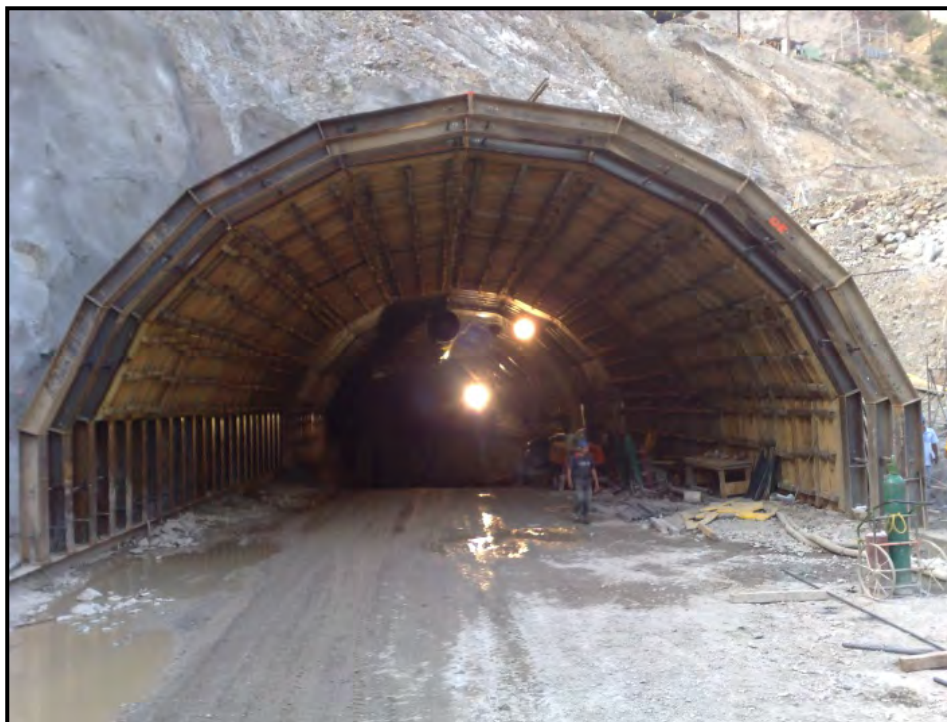
Figura 7.26 Cimbrado con marcos metálicos
