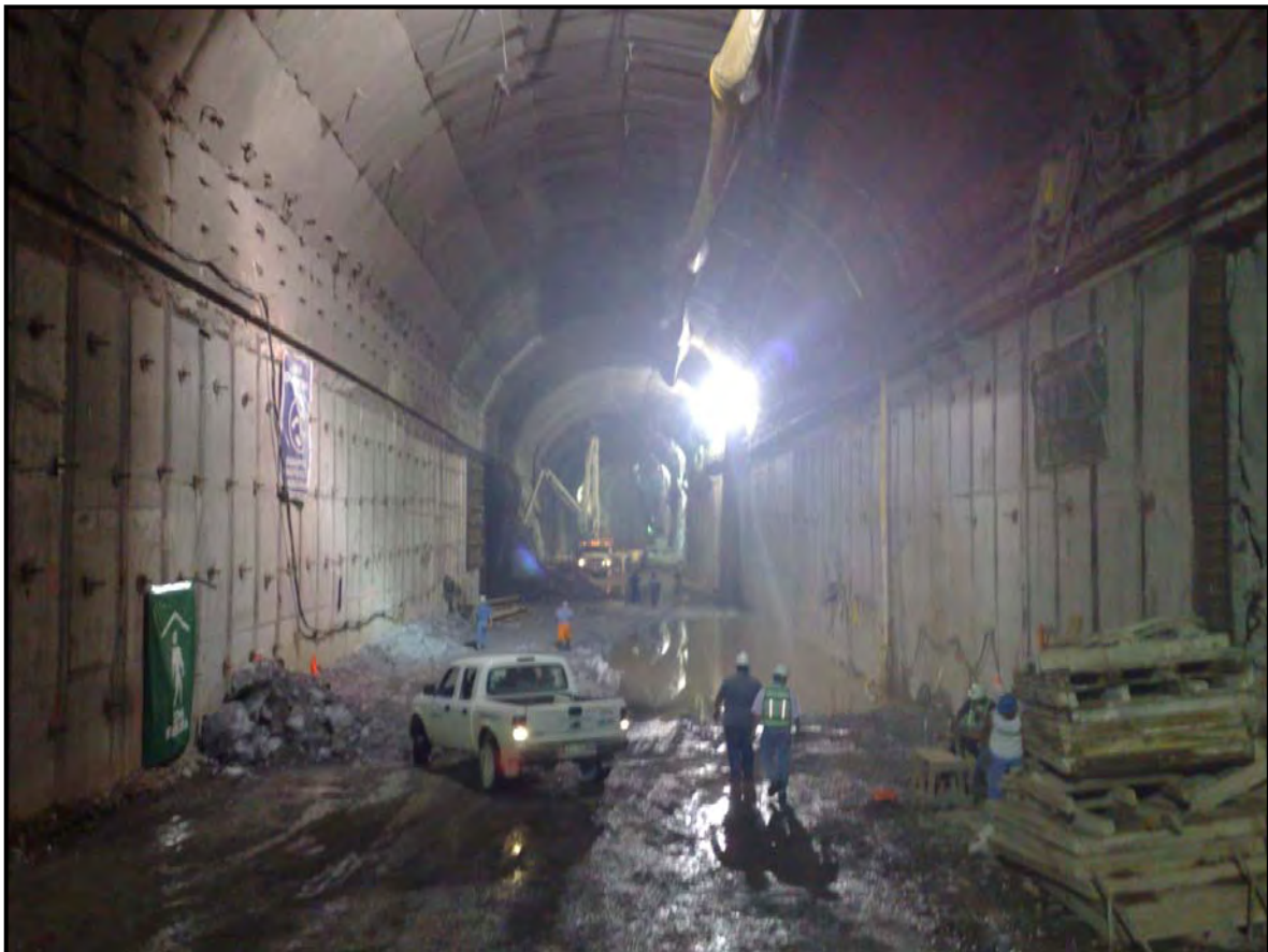
Figura 7.23 Últimos trabajos del revestimiento primario en la sección constante- media sección inferior
