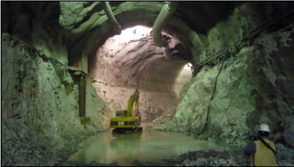
Figura 7.18 Excavación de la media sección inferior
