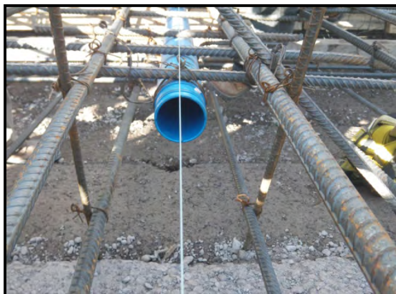
E. Se realiza el acoplamiento de la tubería ABS
