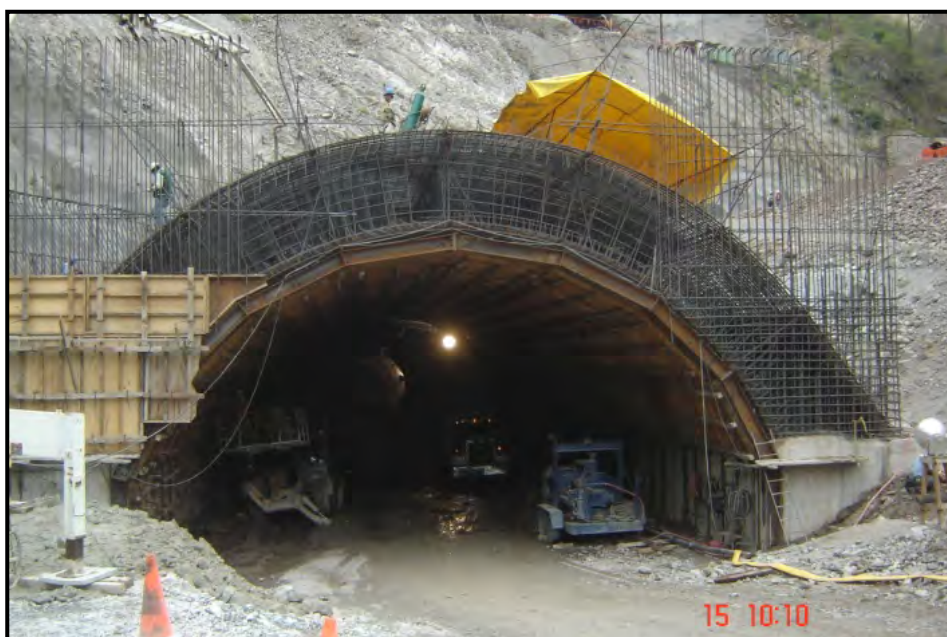
Figura 7.27 Colocación de acero de refuerzo del túnel falso
