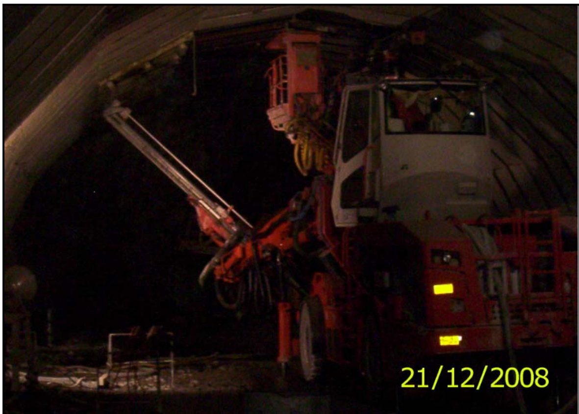
Figura 7.15 Jumbo de tres brazos perforando barrenos
