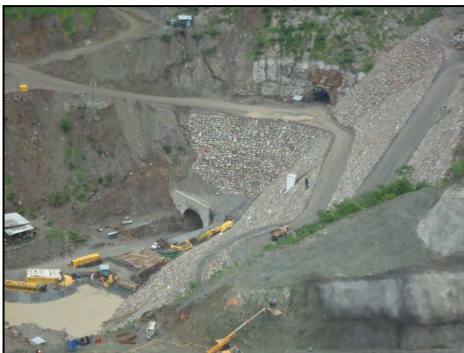
Figura 7.29 Berma y talud del camino concluidos
