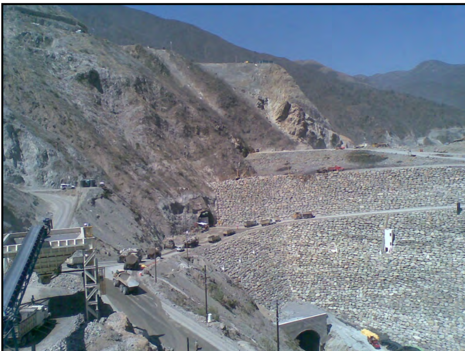
Figura 7.31 Camiones cargados transitando sobre el túnel falso.
