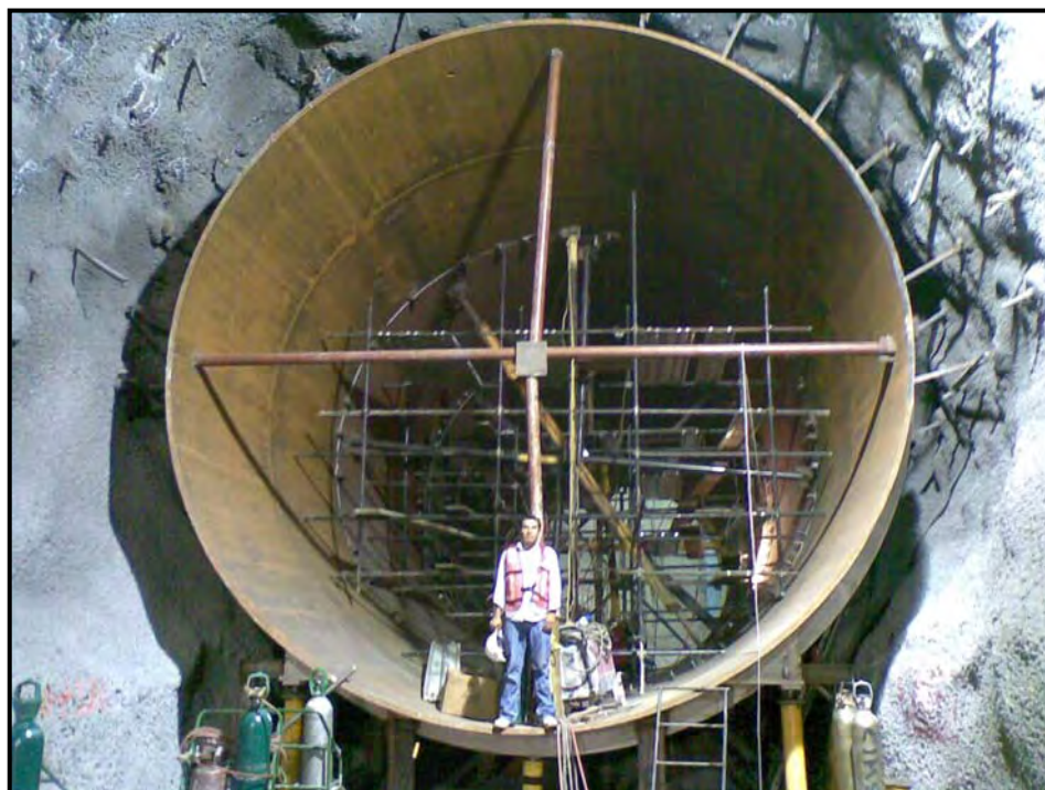
Figura 8.6 Inicio de la instalación de la tubería a presión
