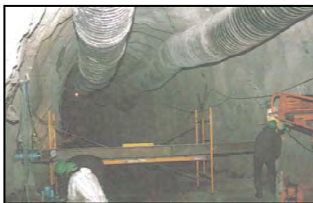
Figura 4.12 Ensayo de placa de carga Ref. [38]
