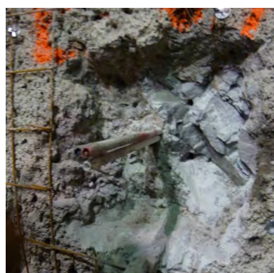
A) concreto retirado para la instalación del cabezal
