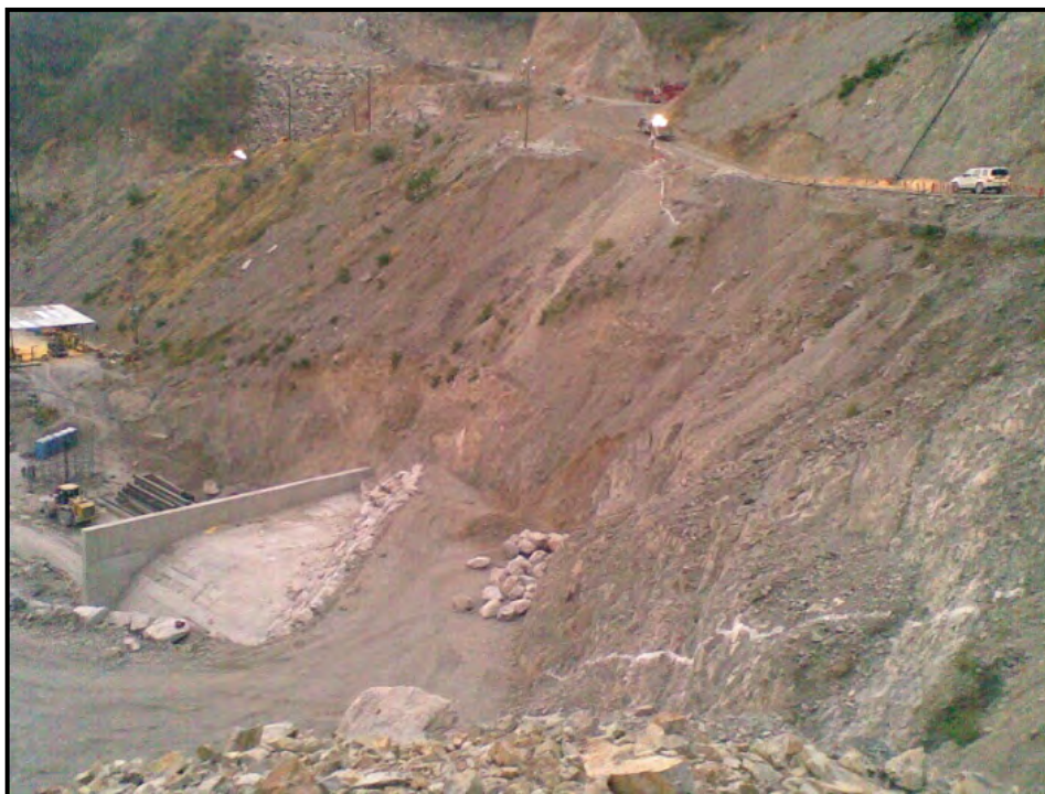
Figura 7.28 Colocación de relleno sobre el Túnel Falso
