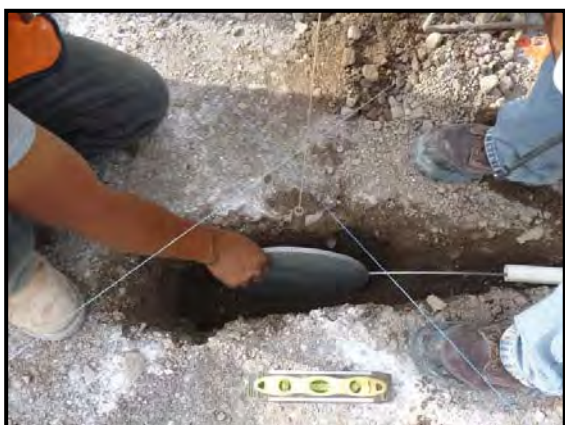
A. Excavación y colocación de la célula de presión
