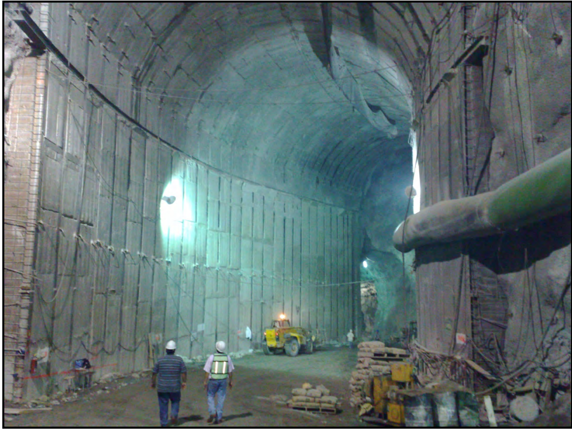
Figura 7.20 Revestimiento primario concluido en la zona de transición (variable) del túnel
