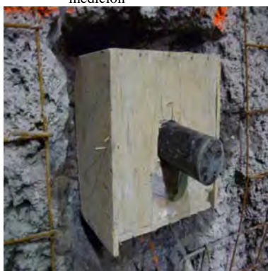
H) Colocación de cimbra
