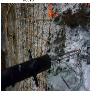
E) Colocación del cabezal de medición
