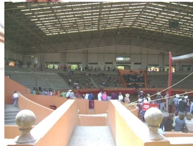
Gradas completamente techadas
