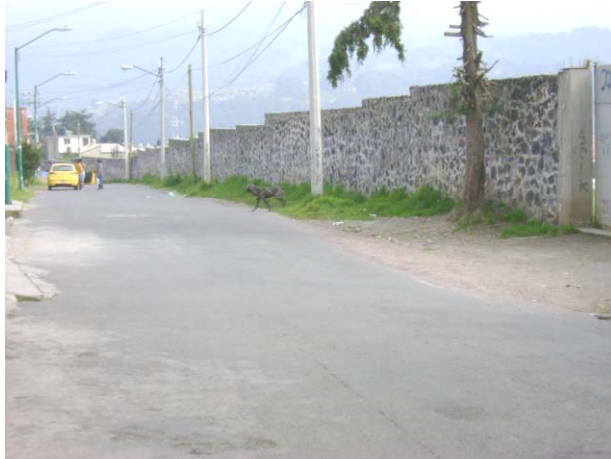
Ausencia de banquetas en Av. Mirador Chapultepec
